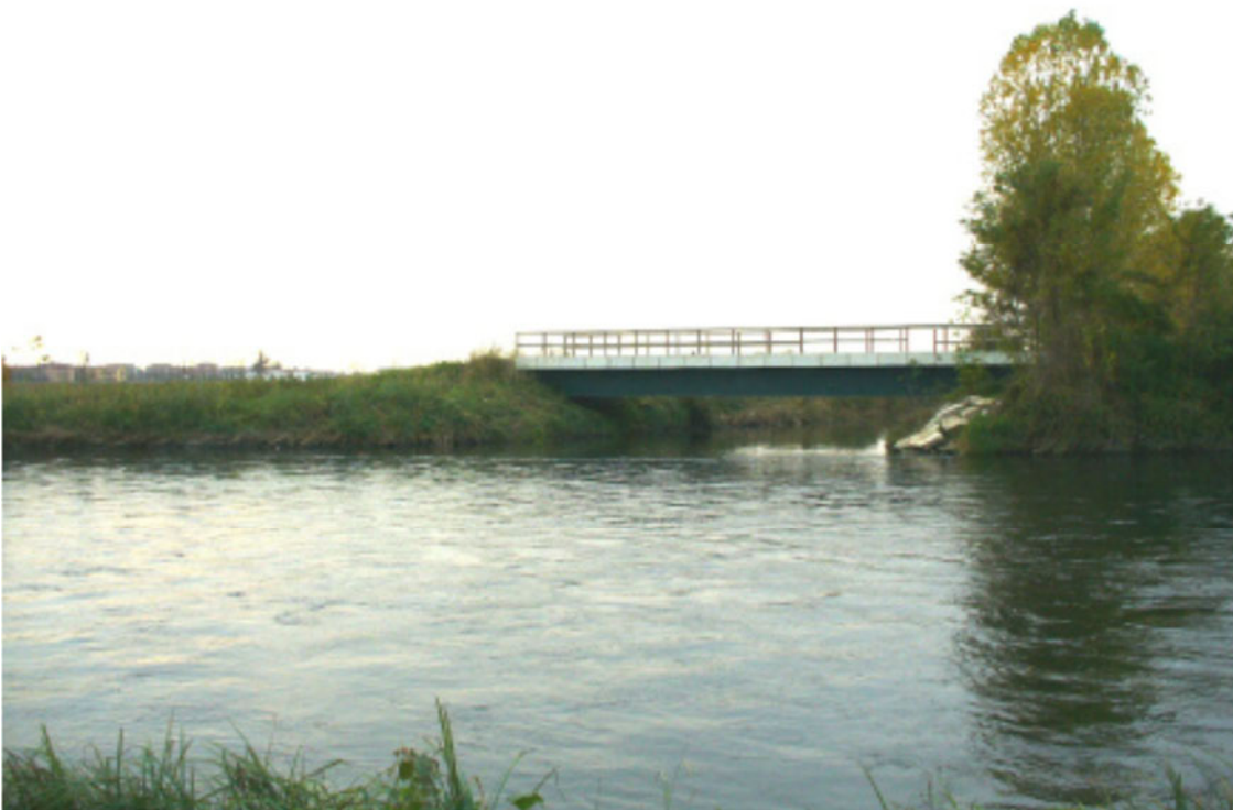
Figura 2.1.18 - Immissione del torrente Molgora nel Canale Muzza prima e dopo la sistemazione della foce e la costruzione del ponte stradale
