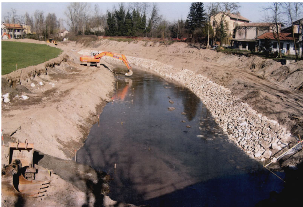
Figura 2.1.21 - Colatore Addetta: traslazione d'alveo e relative opere di difesa a protezione dell'abitato di Balbiano di Colturano
