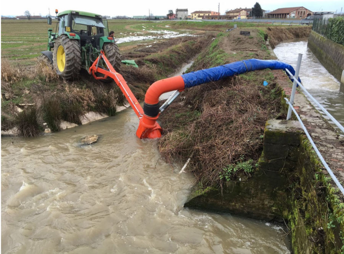
Figura 4.1.3 - Opera di bonifica di soccorso: pompa idrovora mobile posizionata
