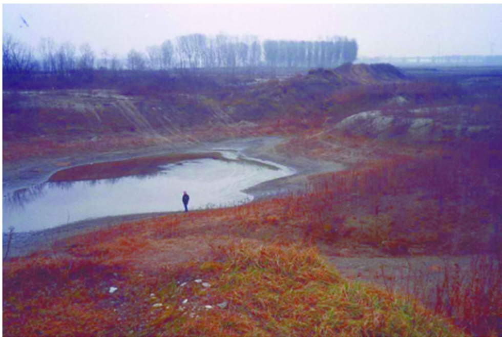
Immagine rottura argine con formazione di grandi voragini
