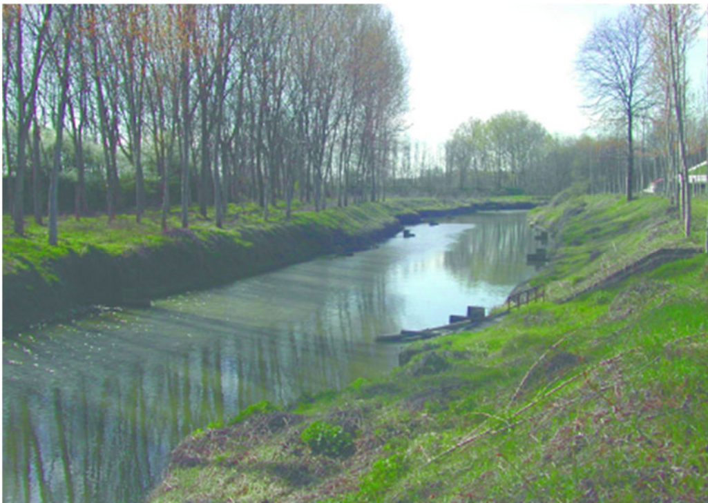
Collettore principale di Bonifica, tratta "Gandiolo" nei pressi di Corno Vecchio
