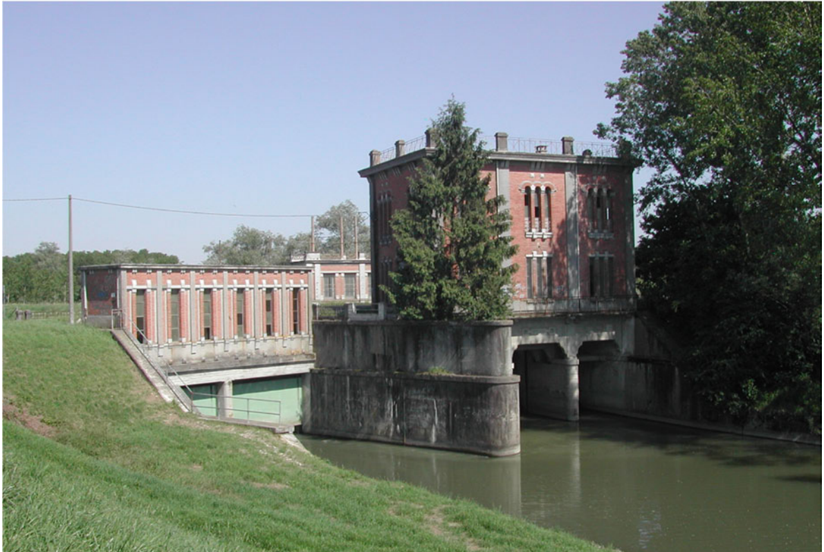
Edificio idraulico di regolazione e scarico "Chiavicone"
