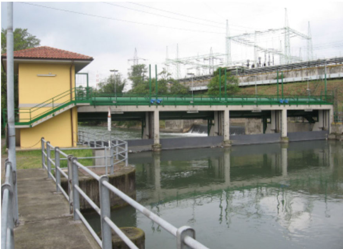
Figura 2.1.17 - Diga di San Bernardino prima e dopo degli interventi di ristrutturazione del 2005 - 2006
