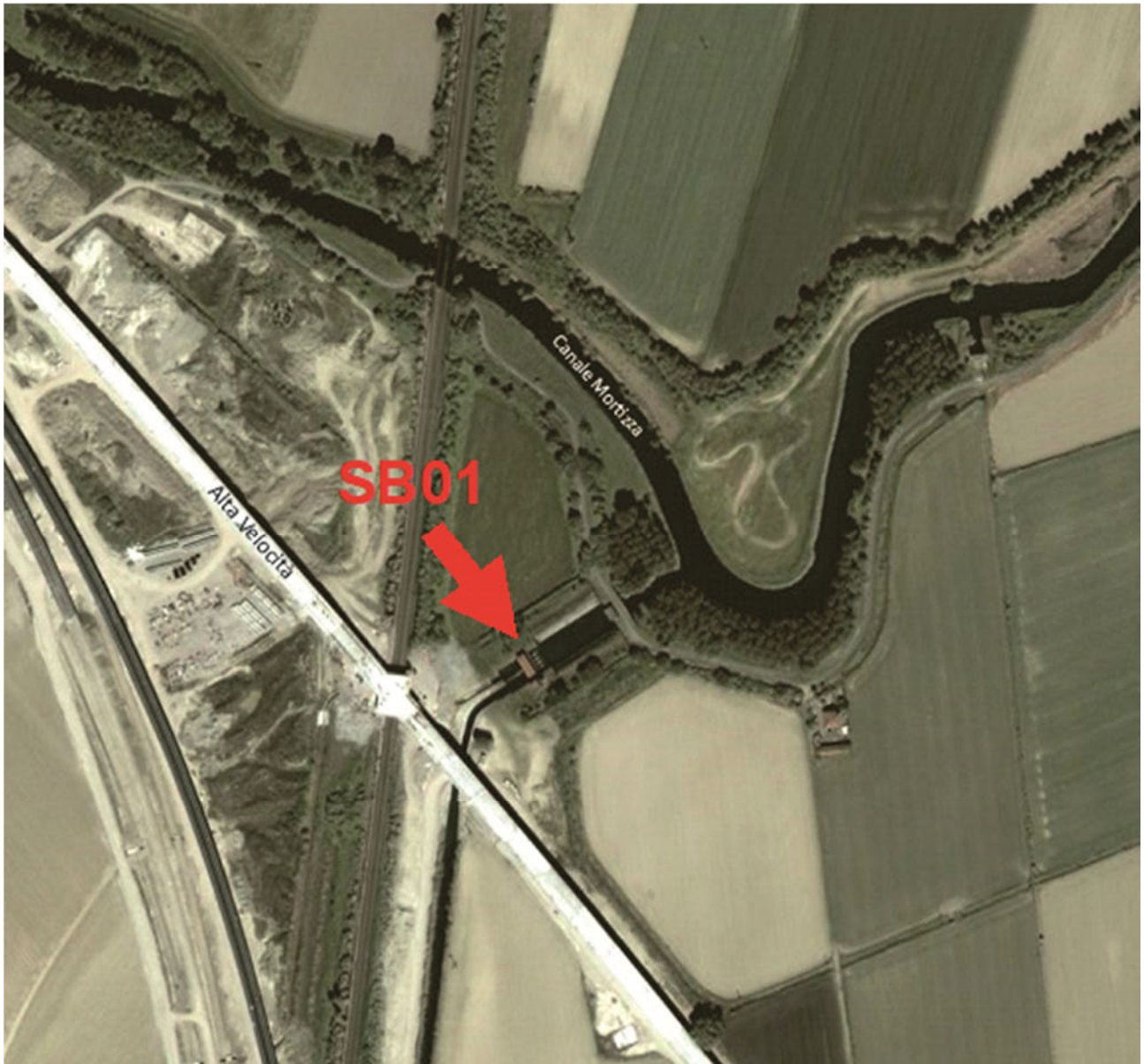
Impianto di bonifica "San Rocco" – ortofoto
