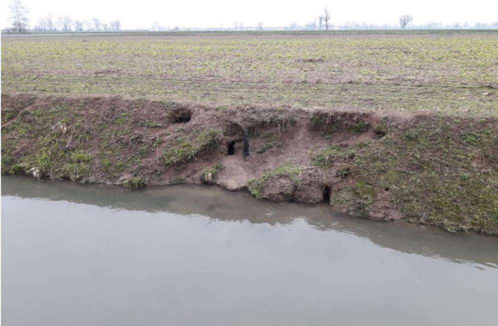
**Figura 6.1.26 – Canale Sillaretto di Villanova oggetto dell'azione delle nutrie**
