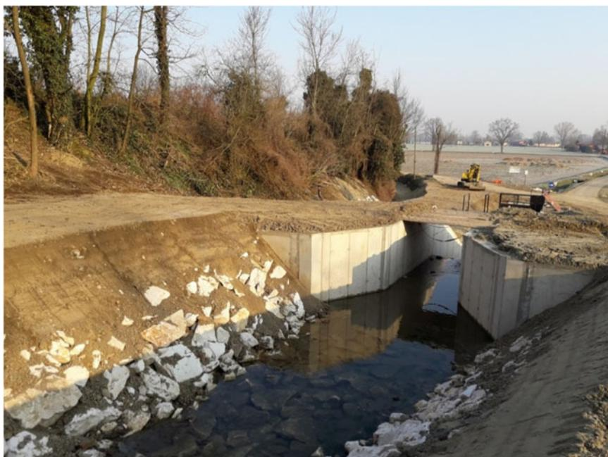
***Fig. 6.2.6 – Manufatto di derivazione delle portate - Lanca di Cavenago d'Adda***
