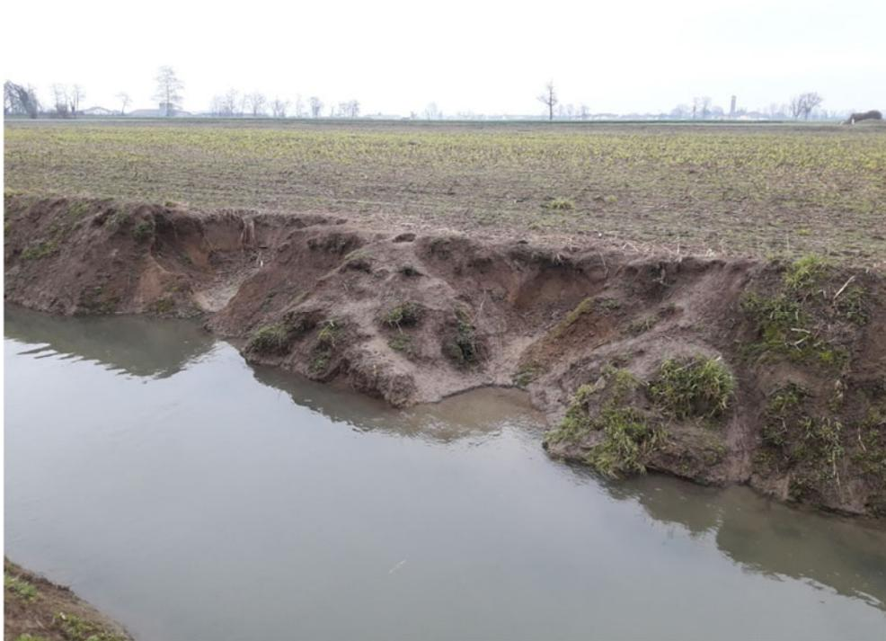
**Figura 6.1.27 – Canale Sillaretto di Villanova oggetto dell'azione delle nutrie**
