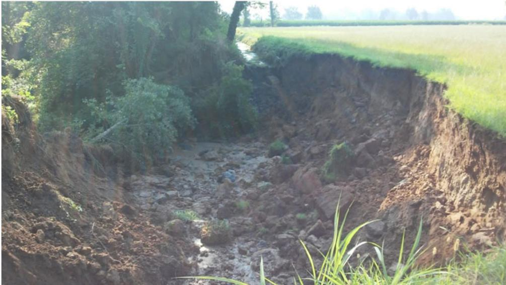
**Figura 6.1.28 - Canale consortile dissestato in seguito all'azione delle nutrie, con danni alle coltivazioni limitrofe**
