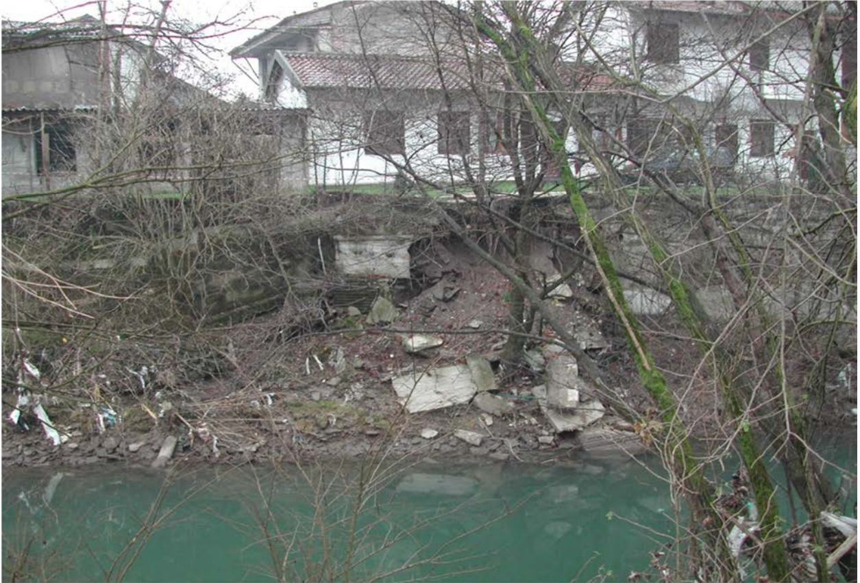
Fig. 6.3.1 – Colatore Addetta: intervento di ripristino statico idraulico a Balbiano di Colturano: situazione ante operam
