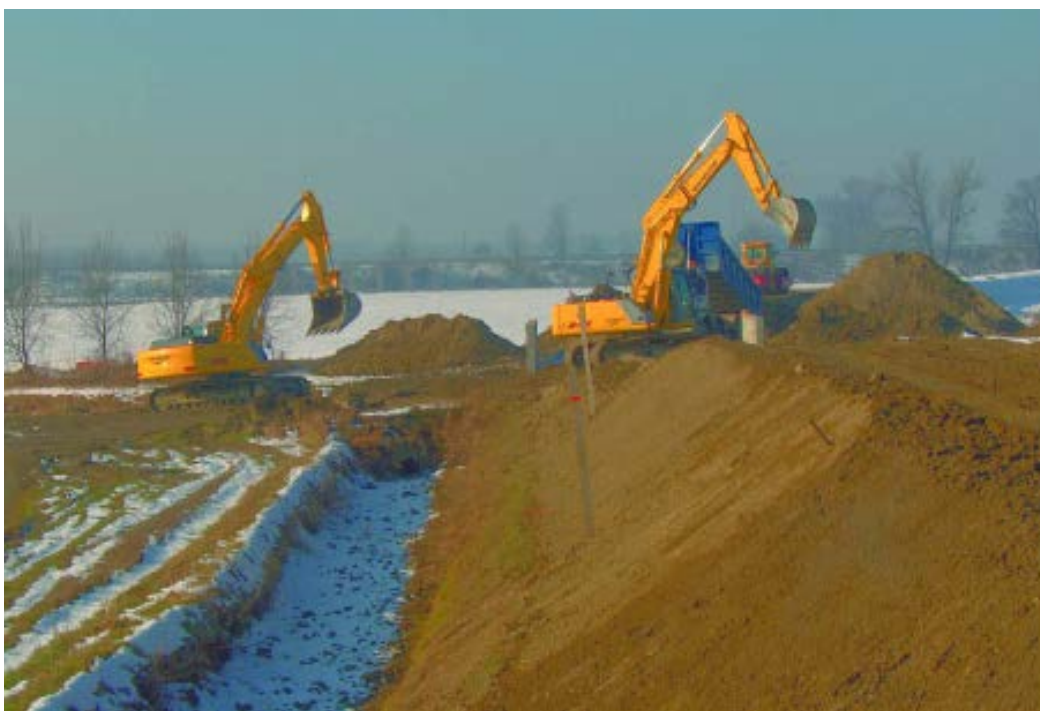
Vasca dissipatrice dell'argine fusibile.
