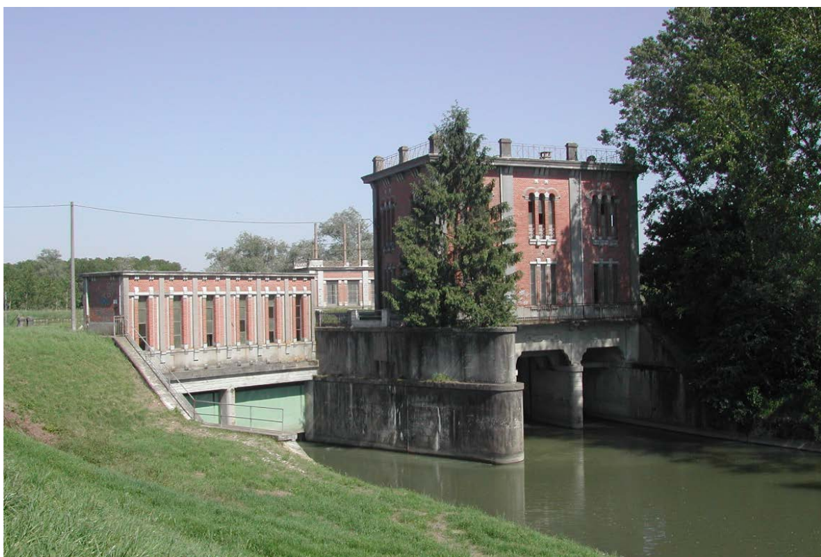
Edificio idraulico di regolazione e scarico "Chiavicone"
