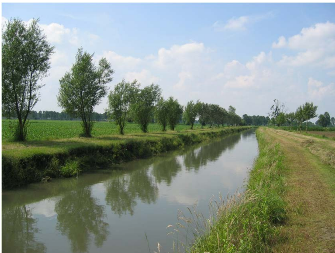
Figura 6.1.17 - Derivatore primario Cà del Parto: connotazione naturale valorizzata con piantumazioni e mantenimento dell'inerbimento dei paramenti spondali
