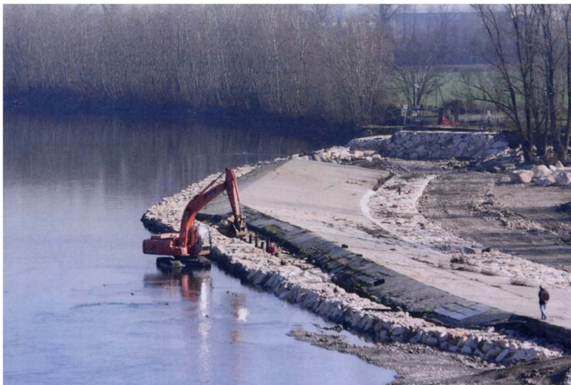
Figura 2.1.19 - Canale Muzza, lavori di ripristino dello sfioratore n°1
