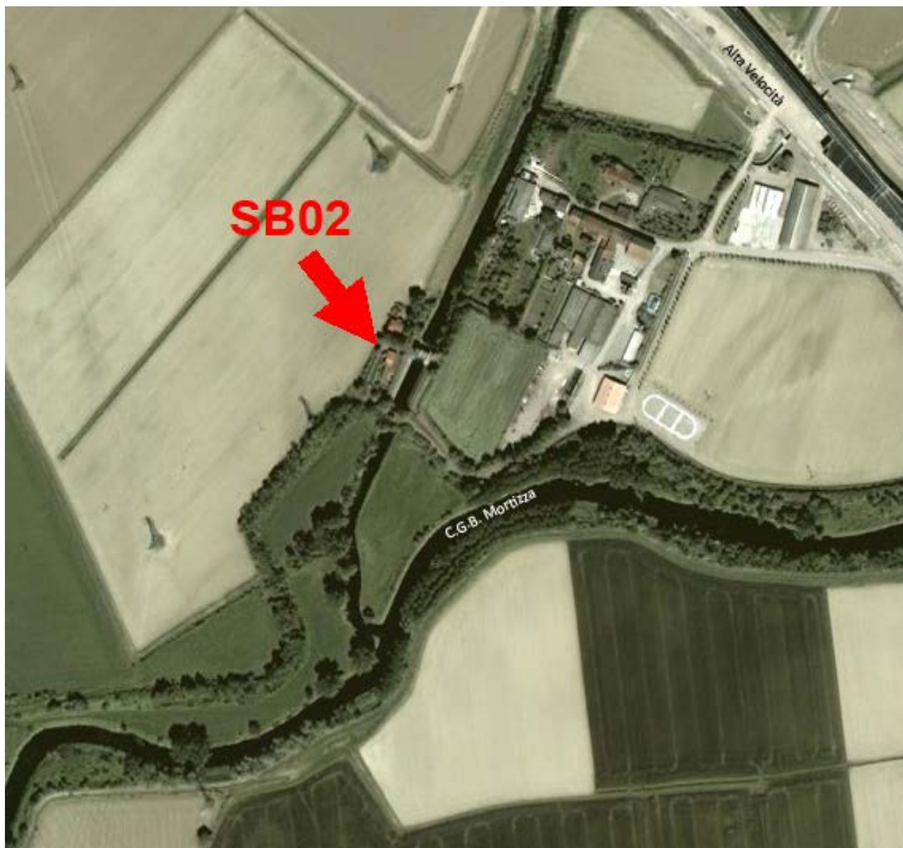
Impianto di bonifica "Resmina" – ortofoto
