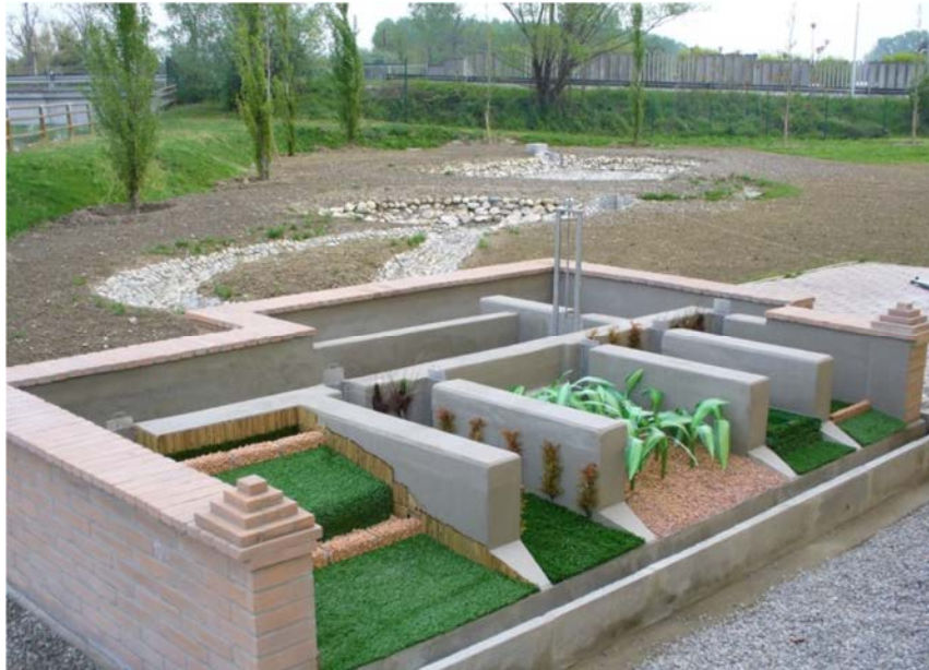
Fig. 6.1.37 – Casa dell’acqua di Paullo: Il modellino idraulico riproducente le diverse modalità di adacquamento irriguo praticate nel comprensorio
