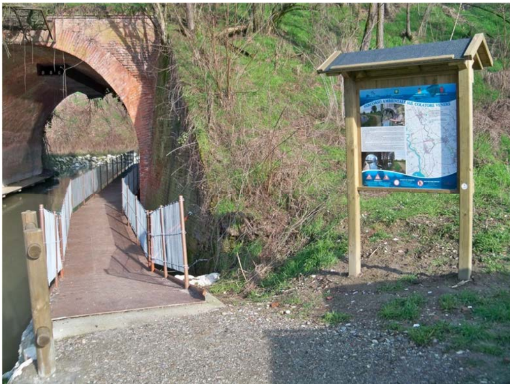
Figura 6.2.3 - Percorso ambientale lungo il colatore Venere: sottopasso alla linea ferroviaria Codogno - Pavia con pontoni galleggianti
