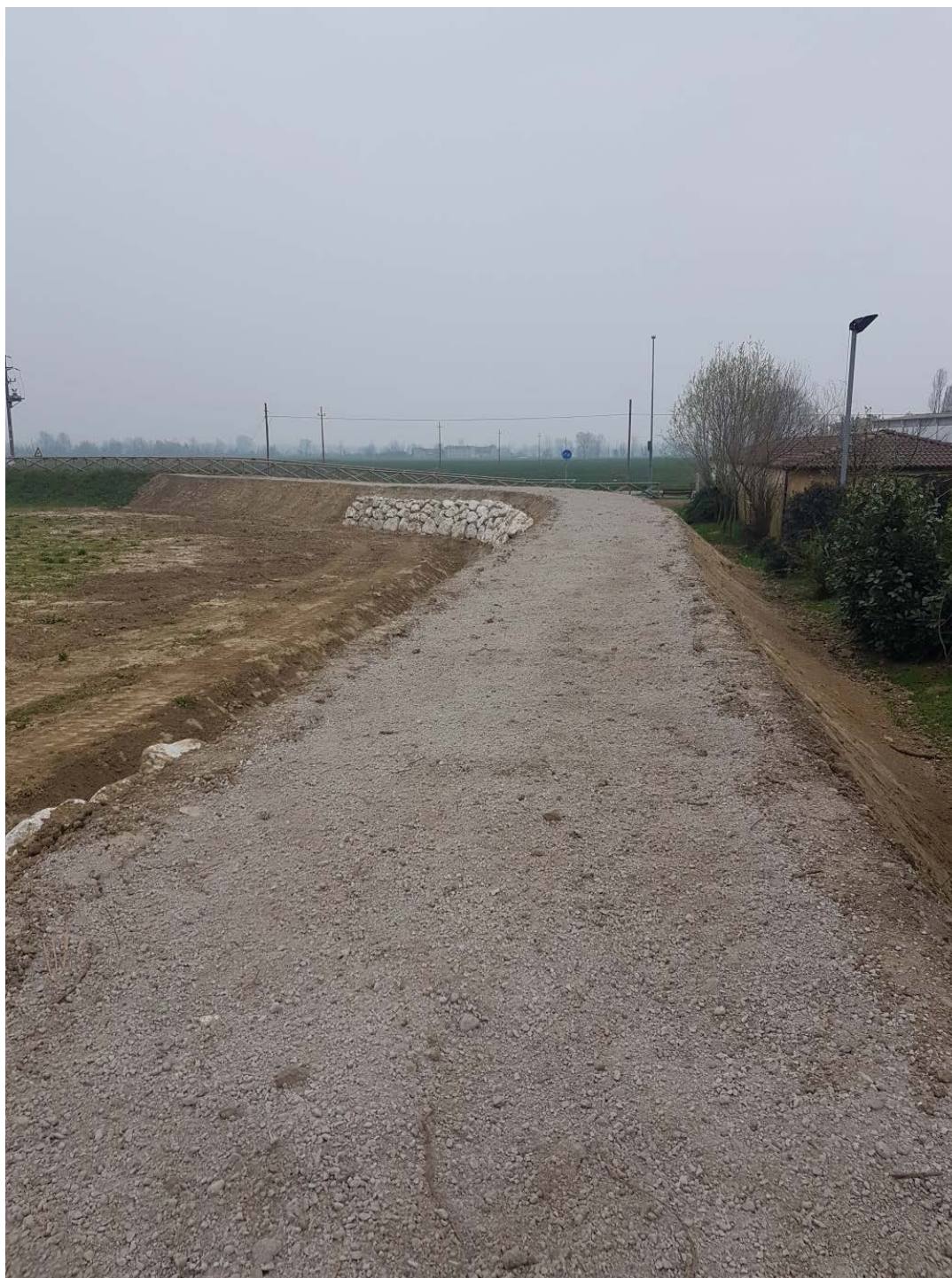
Immagini argini torrente Molgora a difesa del centro abitato di Lavagna
