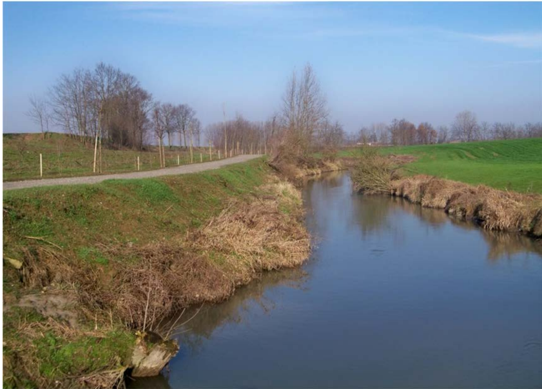
Figura 6.1.1 – Colatore consortile con paramenti spondali naturale e strada alzaia piantumata
