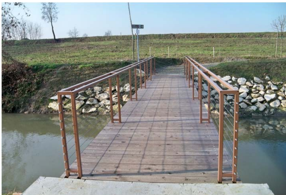
Figura 6.2.4 - Percorso ambientale lungo il colatore Venere: passerella di sovrappasso al colatore per la diversione del tracciato
