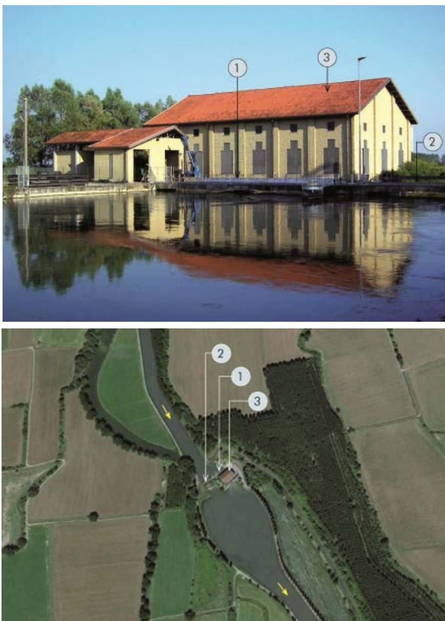
Fig. 5.1.5 - Schema della centrale idroelettrica Bolenzana: Le portate vengono dirette all'opera di presa (1) preceduta da una griglia pulita in automatico da apposito sgrigliatore mobile. All'interno del fabbricato (3) sono installate la turbina/e (singola o coppia in parallelo). Il carico di monte e i deflussi nelle macchine sono assicurati da uno sbarramento mobile automatico (2) costituito da paratoia/e a ventola (uno, due o tre). Il sistema, è automatico, telecontrollato e telerilevato.
