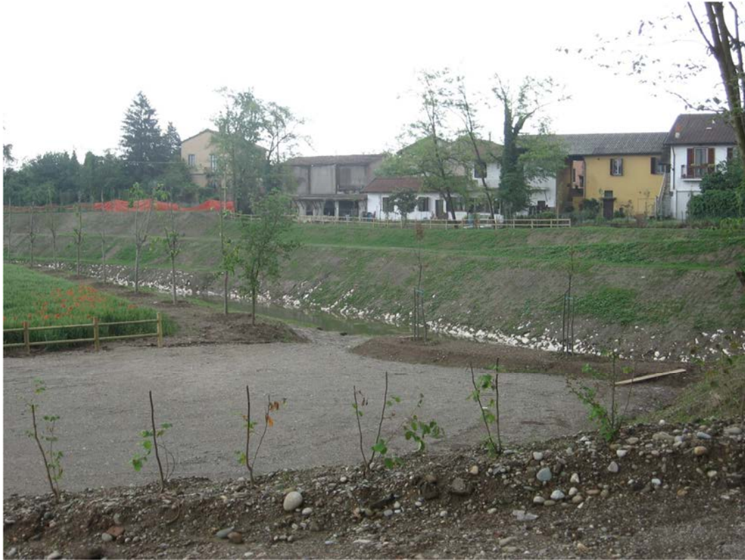
Fig. 6.3.8 – Riquilificazione idraulico – ambientale del colatore Addetta a Balbiano: tratto a monte del ponte urbano
