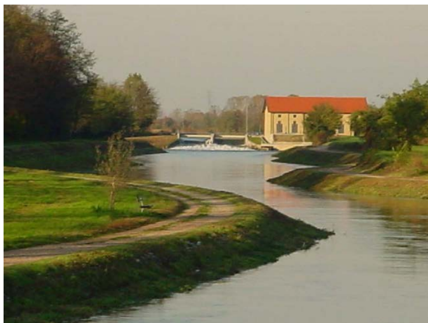
Fig. 5.1.7 - Centrale di Quartiano vista da valle, l'arredo "verde" del canale con percorso, aree di sosta e vegetazione perispondale sono stati eseguiti nel contesto realizzativo dell'impianto.
