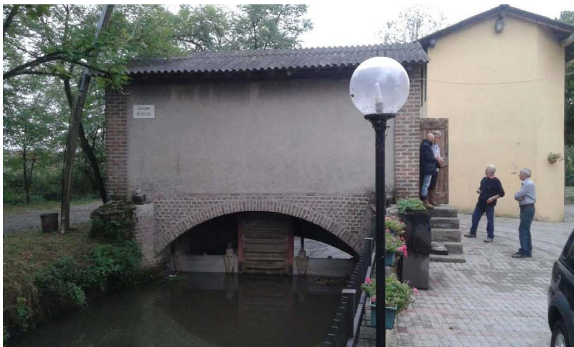
Figura 4.2.10 - Opera di presa del Cavo Marocco.
