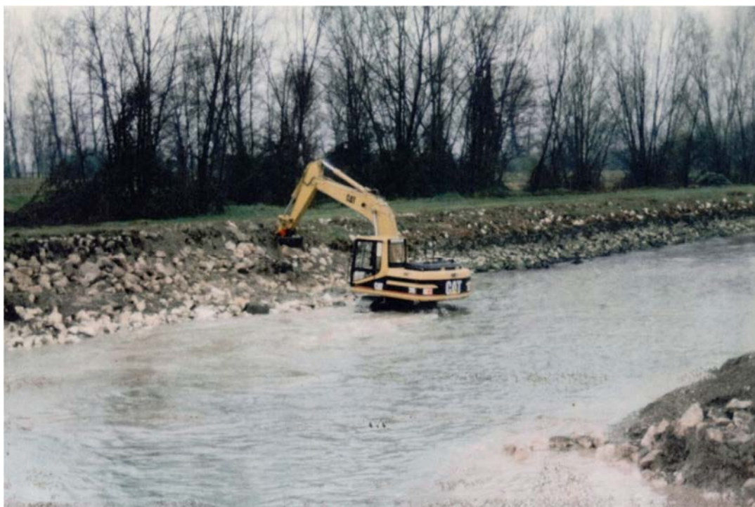
Figura 2.1.20 - Canale Muzza. Località Comazzo. Ripristino della sponda destra a seguito di una frana. Lavori in alveo ad acqua fluente
