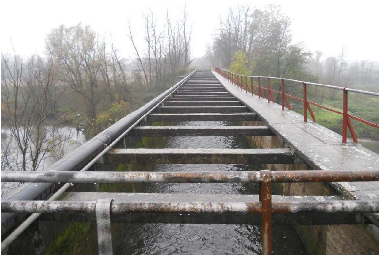
4.2.11 - Comune di San Zenone al Lambro, manufatto di sovrappasso del Cavo Marocco al Fiume Lambro.
