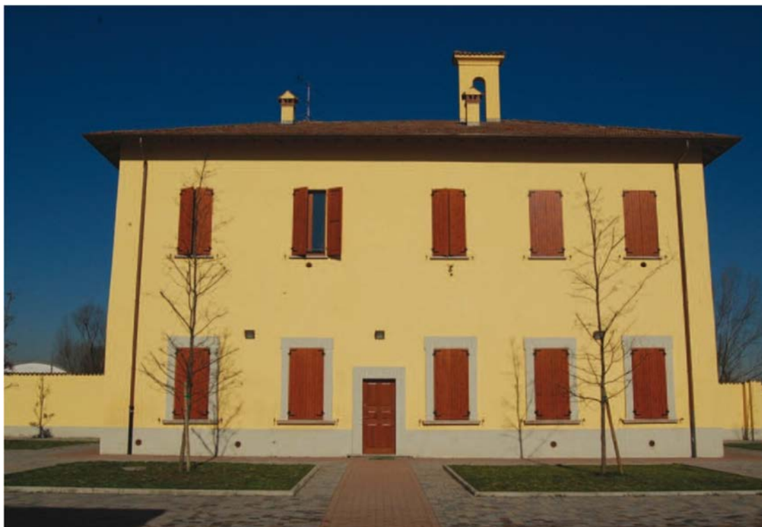
Fig. 6.1.36 - Casa dell'acqua di Paullo: il fabbricato principale a seguito della ristrutturazione conclusasi nel 2006
