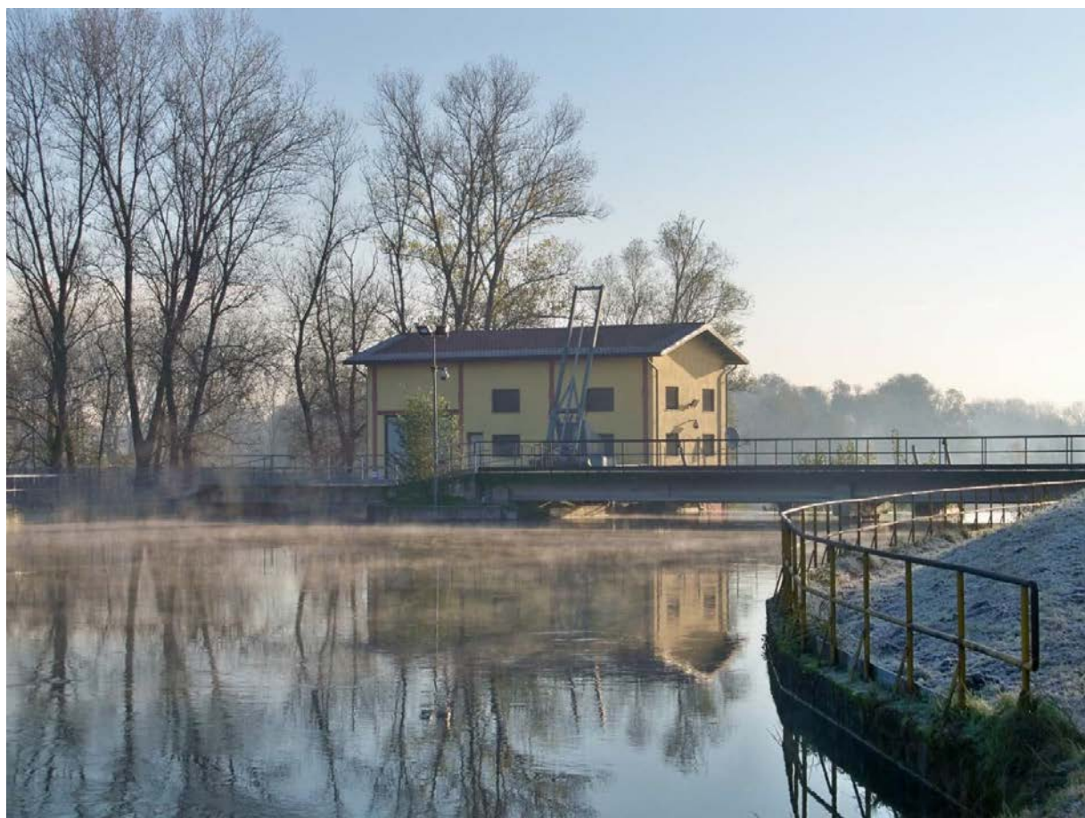
Figura 5.3.1 Centrale idroelettrica Belgiardino 2 sull'omonimo scaricatore
