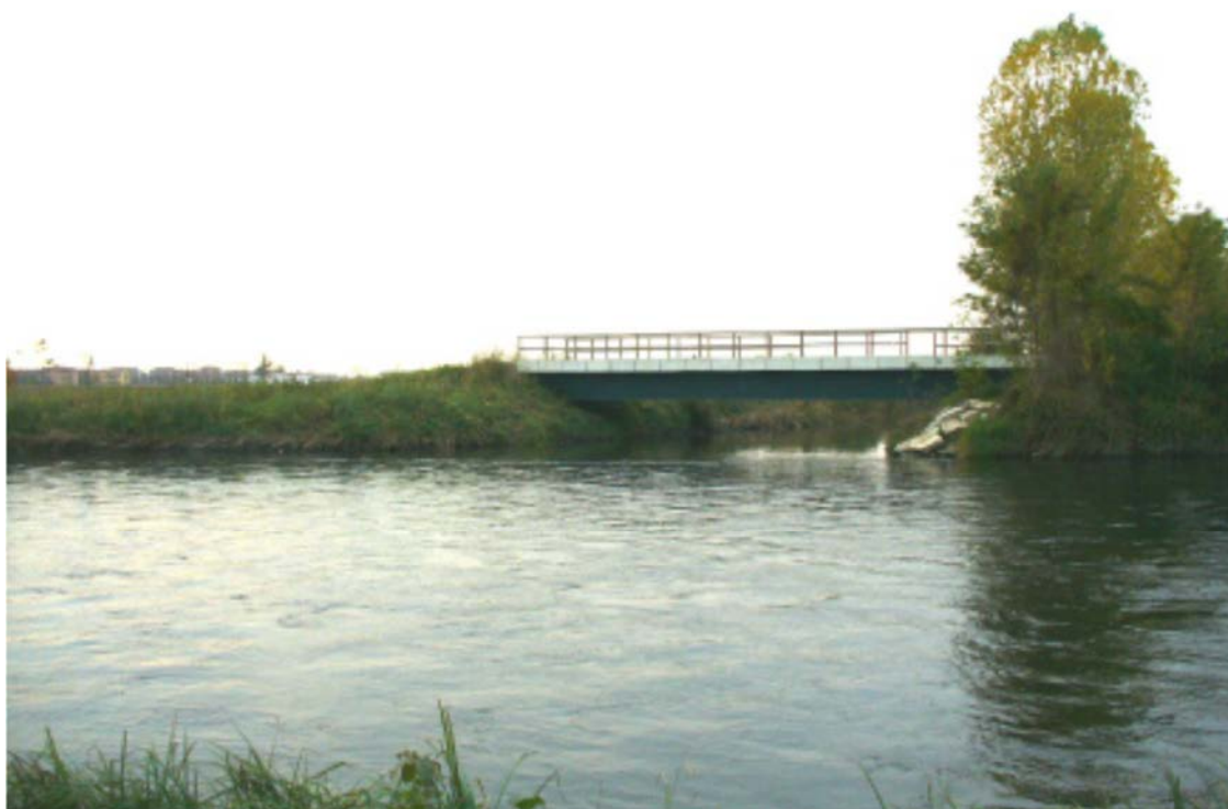
Figura 2.1.18 - Immissione del torrente Molgora nel Canale Muzza prima e dopo la sistemazione della foce e la costruzione del ponte stradale
