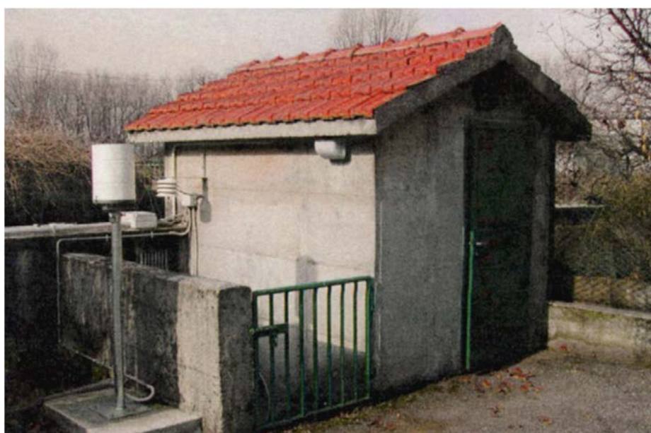
Figura 2.1.22 - Diverse collocazioni di centraline di telerilevamento
