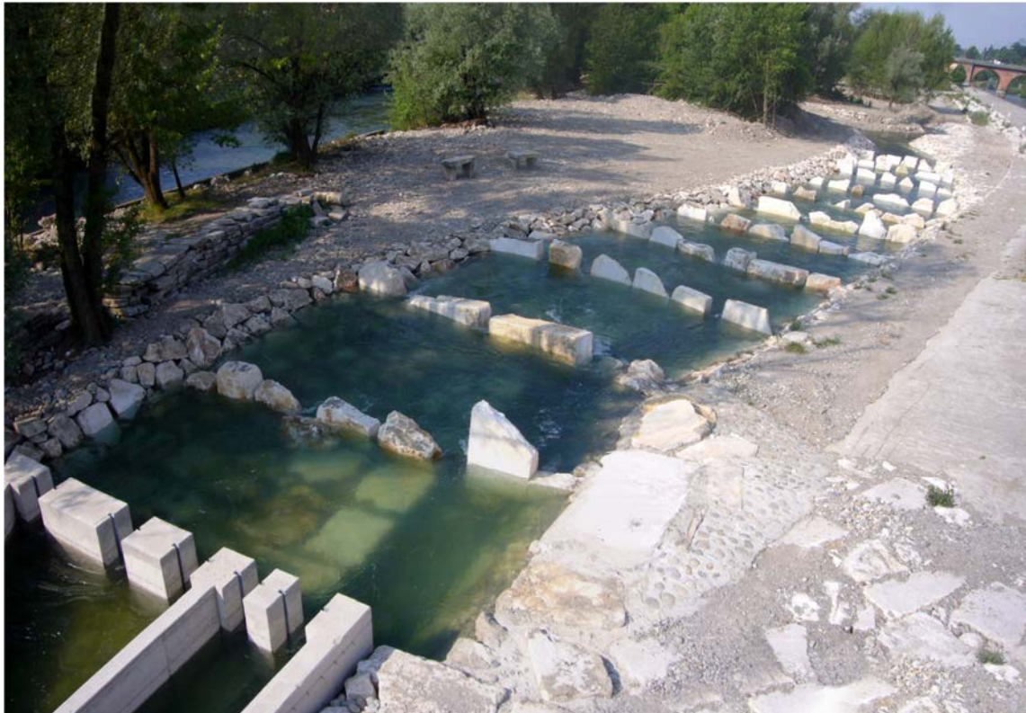
Figura 6.1.5 – Scala di rimonta ittica al manufatto sfioratore Traversino di Cassano d’Adda
