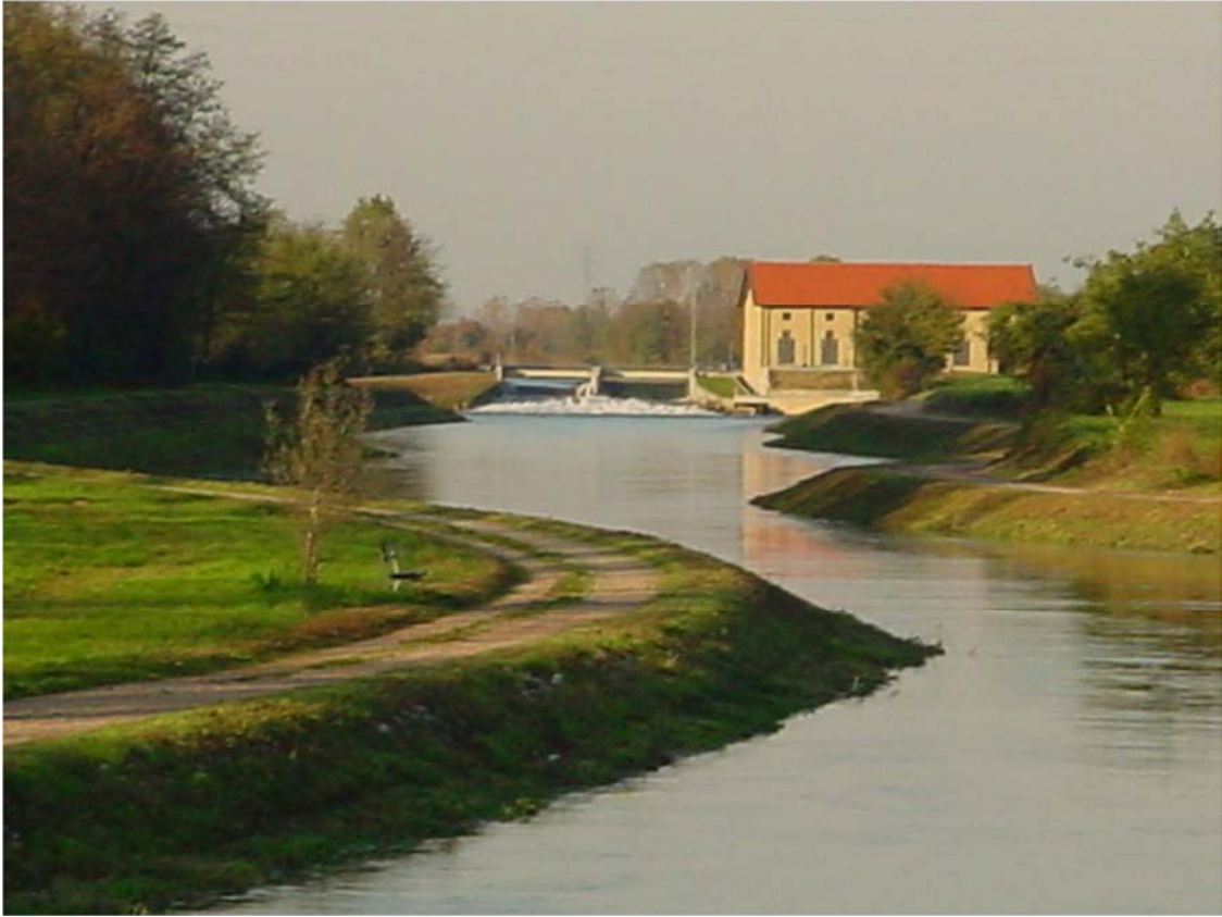
Figura 6.1.3 – Centralina idroelettrica di Quartiano sul canale Muzza
