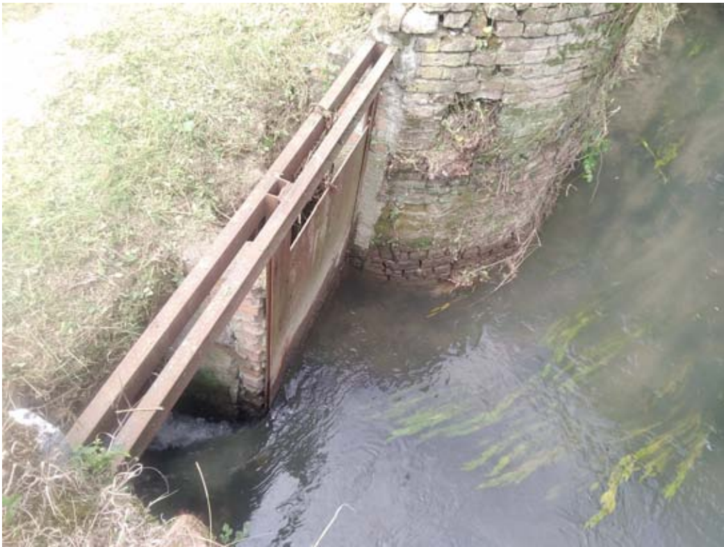
Particolare paratoia scarico
