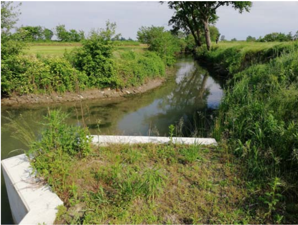
Tratto a valle del manufatto di scarico
