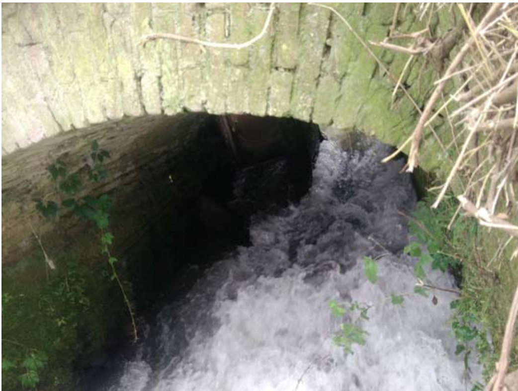
Particolare volta ponte
