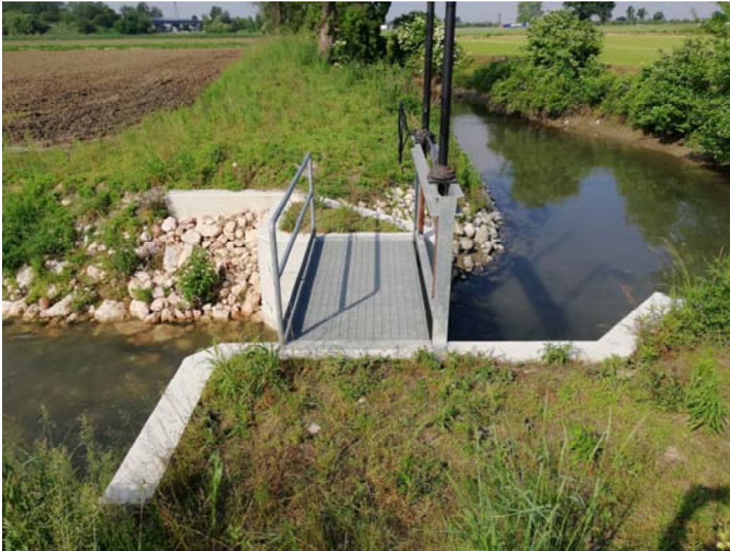
Manufatto di scarico esistente del colatore Sillaro in colatore Sillaretto (punto M)
