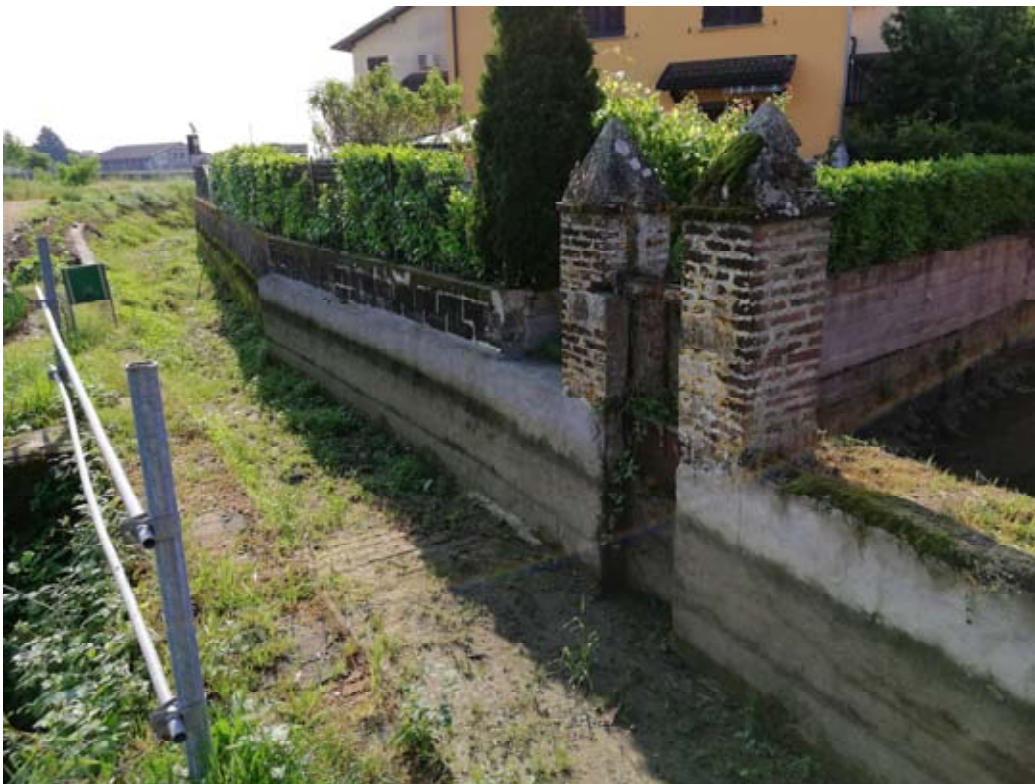
Ponte canale (Punto N)
