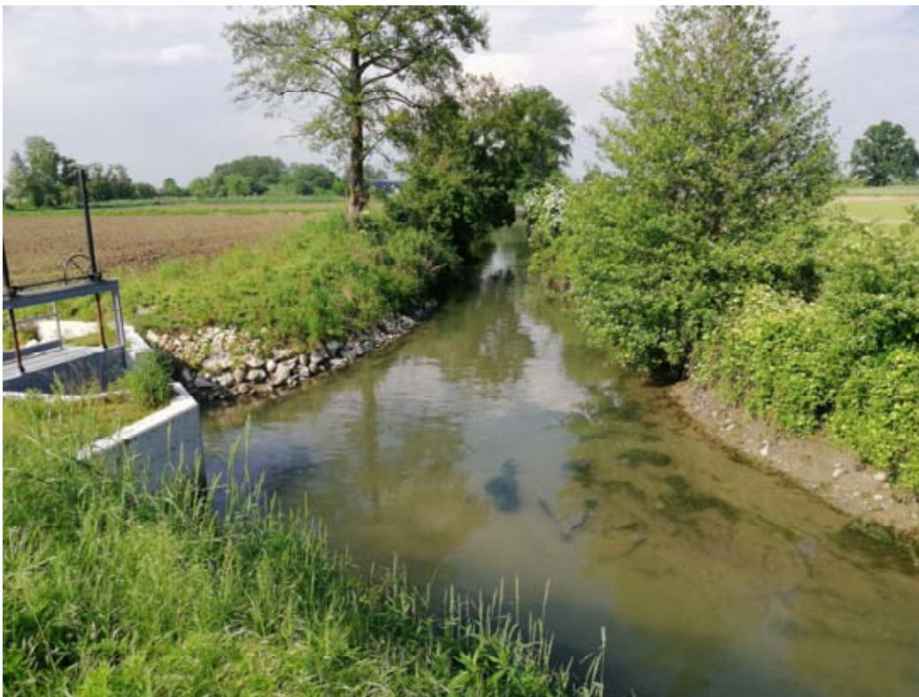
Tratto a monte del manufatto di scarico
