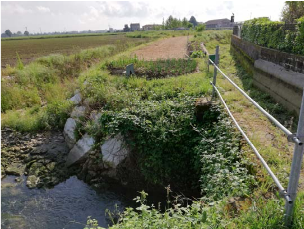
Starda di servizio esistente (Punto N)
