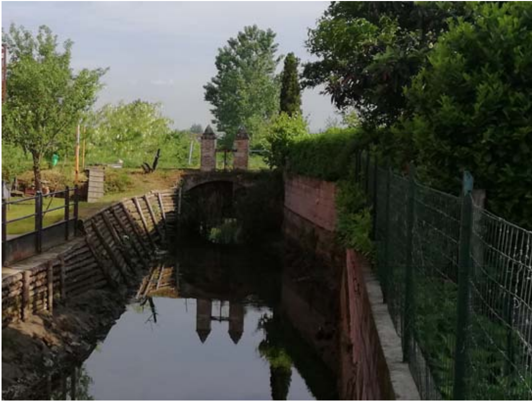
Manufatto ponte canale vista da valle (Punto N)
