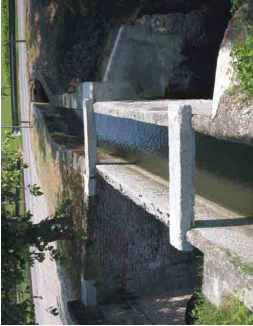
Ponte - canale in granito
