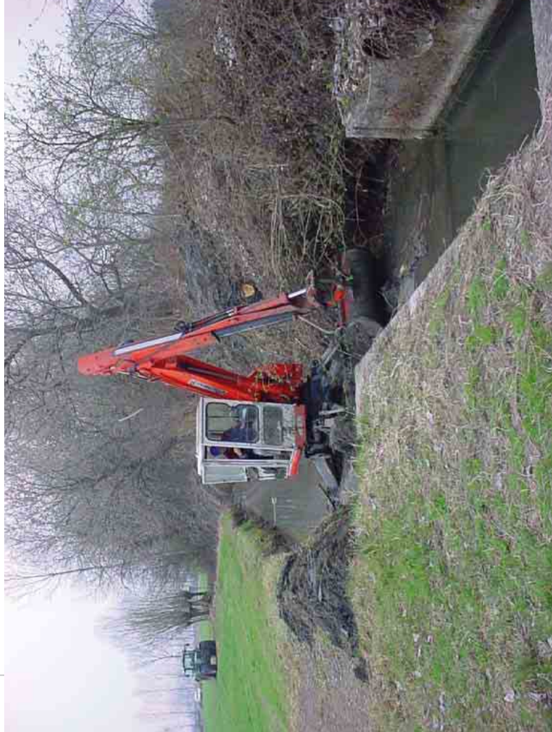
Spurgo meccanico di un canale mediante l'utilizzo di escavatore tipo "regno"
