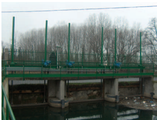
Paratoie dello scaricatore Addetta visto da monte. Il dispositivo di apertura e chiusura dei diaframmi delle paratoie avviene tramite motorizzazione elettrica, la regolazione è automatica telerilevata e telecontrollabile.
