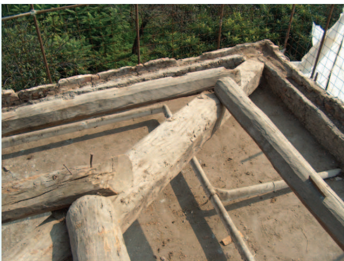
Particolare di come si presentava il colmo del tetto dell'edificio principale (1) dopo la rimozione dell'orditura minore.
