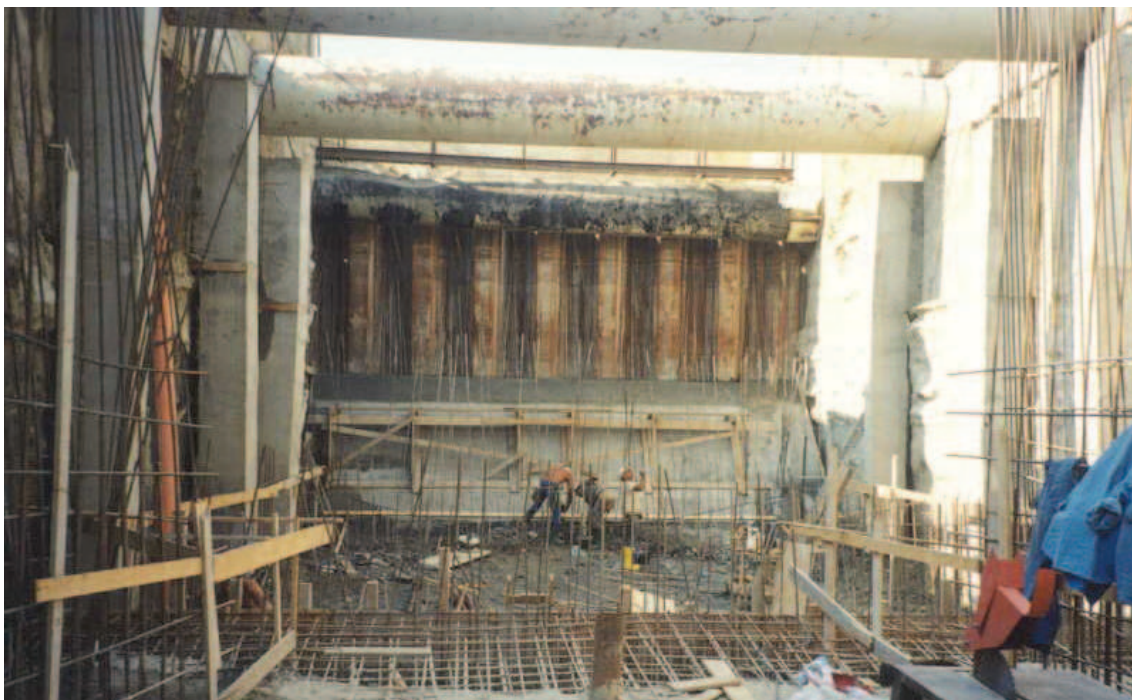
Una fase dei lavori di realizzazione delle platee di fondo della centrale. Molte lavorazioni sono state eseguite sotto il livello idrico del canale Muzza in esercizio (circa 5 m); ciò ha comportato l'applicazione di specifiche tecniche di "isolamento" e difesa dai deflussi del canale stesso.
