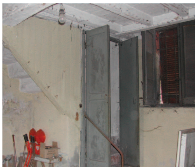
Edificio colonico (2): situazione a inizio lavori.
