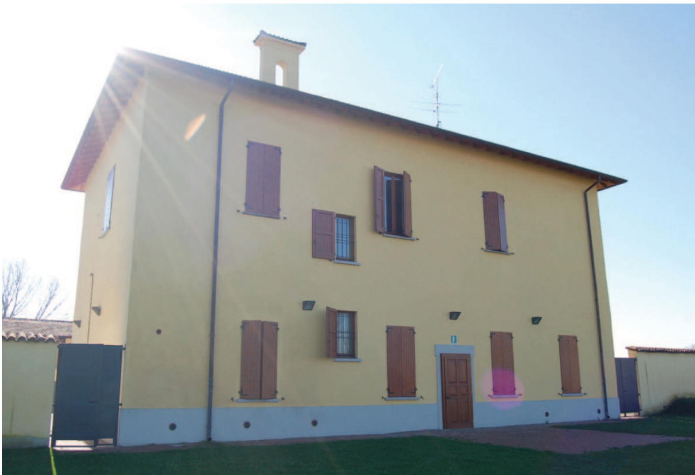
Facciata verso il giardino a fine lavori.
