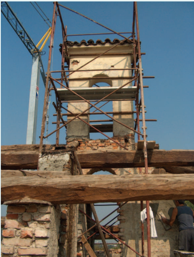
Particolare della ricostruzione della torretta campanaria nell'edificio principale (1).
