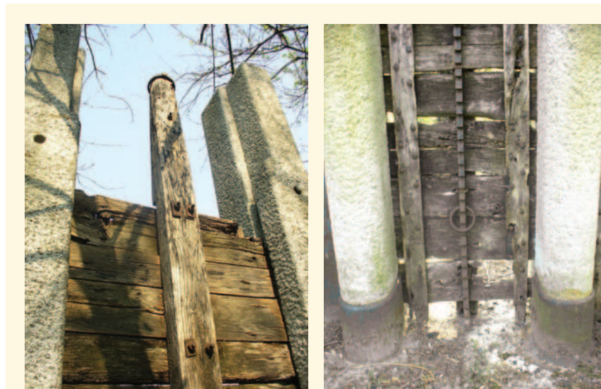
2 immagini fotografiche di particolari delle paratoie con vista da monte e da valle.
