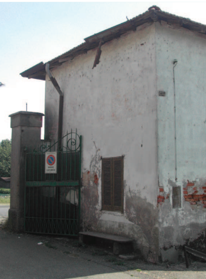
Edificio colonico (2): stato di fatto prima dei lavori di restauro.
