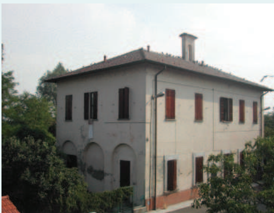
Stato di fatto dell'edificio principale (1) visto sul lato occidentale e meridionale.
