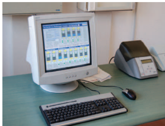
Interno dell'edificio dove è presente la postazione di controllo.
