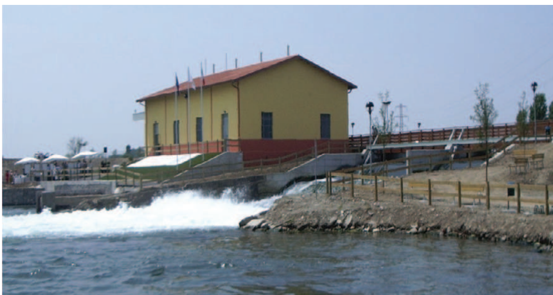
La centrale idroelettrica di Paullo, durante i lavori e il giorno dell'inaugurazione (30/05/2004).
