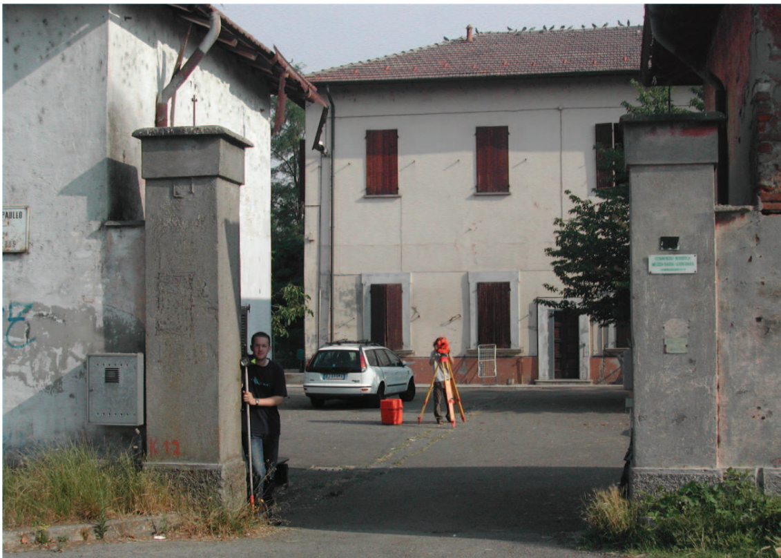
Una fase di rilievo topografico.
