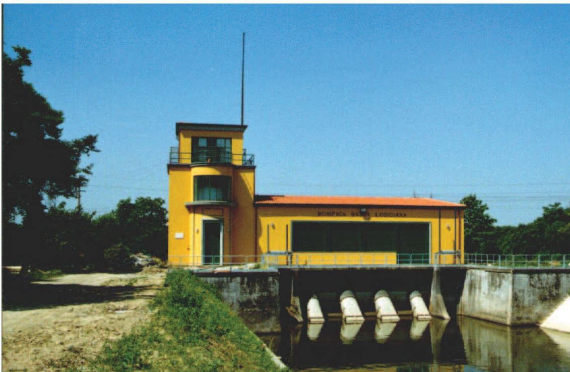
Tutti gli impianti funzionano in modo automatico in relazione alla misura istantanea dei livelli idrometrici. Avviamento e spegnimento sono telerilevati e telecontrollati a distanza con sistemi computerizzati. In alcuni di essi sono installate specifiche apparecchiature per la registrazione meteo-ambientale (temperatura, aria, piovosità, acqua, ecc.).
