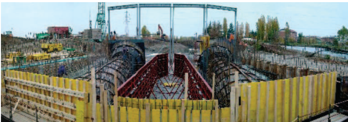
Centrale idroelettrica di Paullo: vista da monte della installazione del corpo strutturale della turbina (immagine gentilmente fornita dalla Quattordici S.p.a.).
