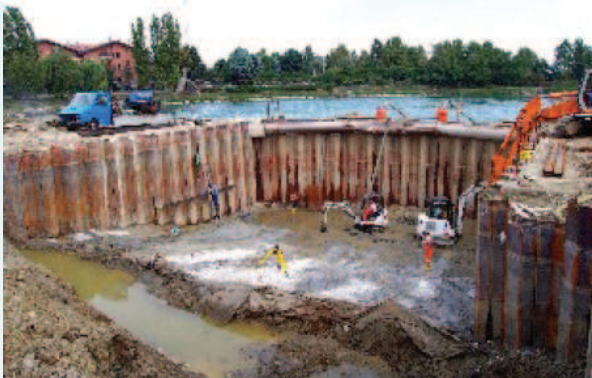
Uno tra i momenti più difficili della realizzazione della centrale idroelettrica di Paullo. L'area operativa è stata "isolata" dal Muzza con uno specifico "box" metallico che consentiva di eseguire le opere in assenza d'acqua (immagine gentilmente fornita dalla Quattordici S.p.a.).
