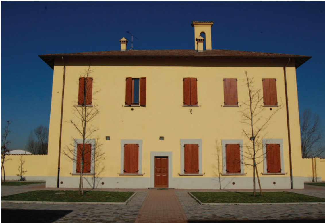
Facciata principale a fine lavori.
