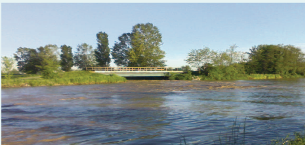
Torrente Molgora – immagine di un evento ordinario di piena in corrispondenza del punto di immissione nel canale Muzza.
