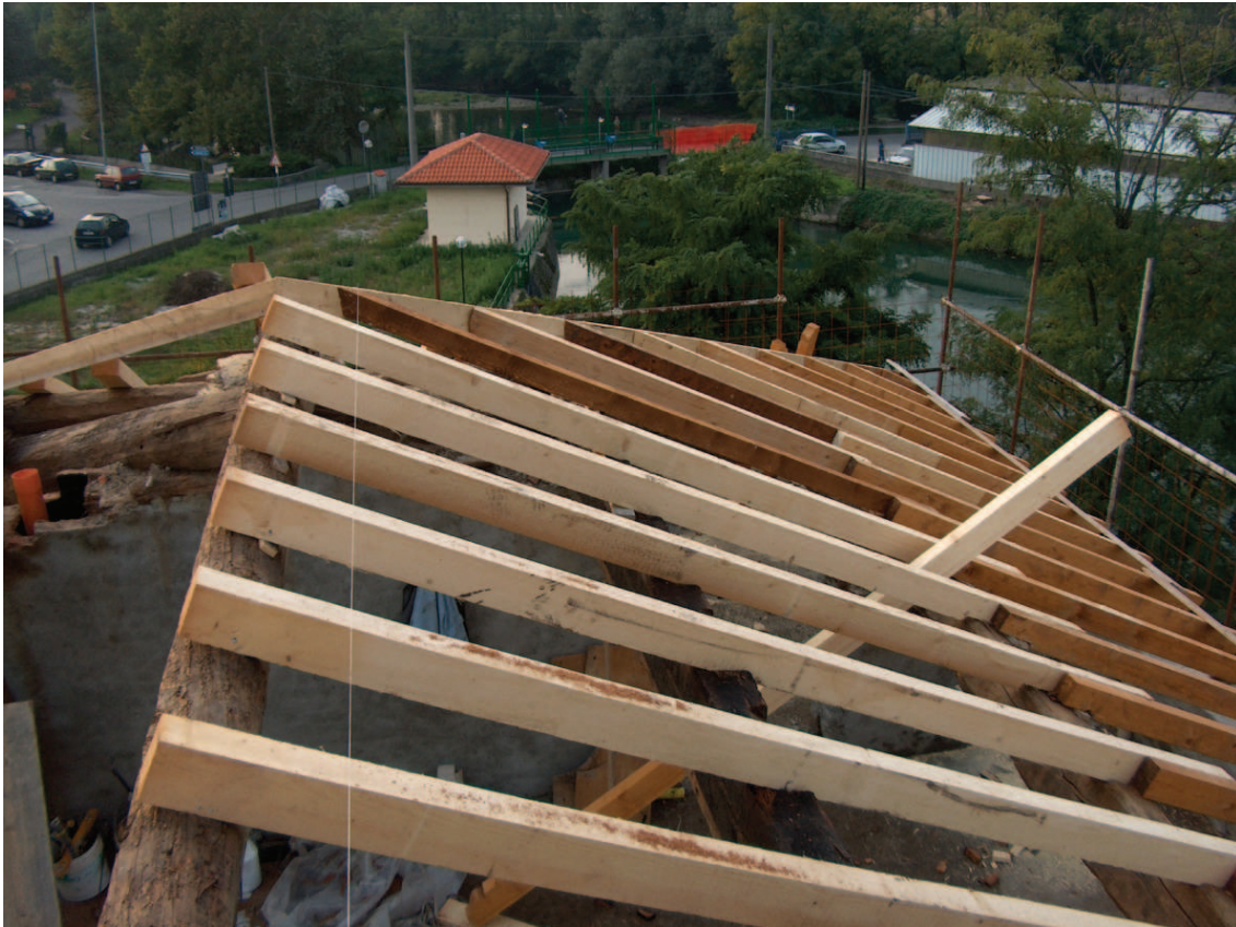
Particolare della ricorso del tetto con sostituzione dell'orditura secondaria.
