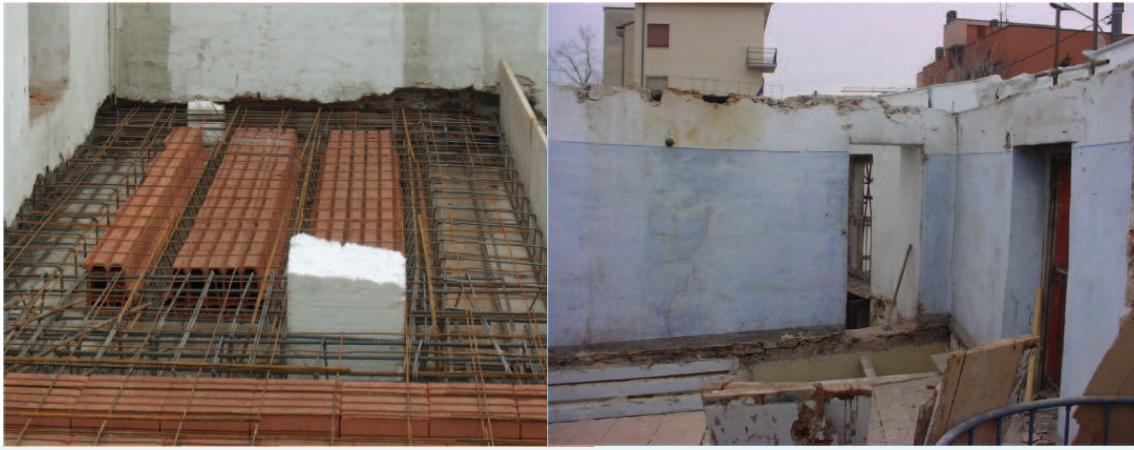
Edificio colonico (2): esecuzione dei nuovi solai in c.c.a.
