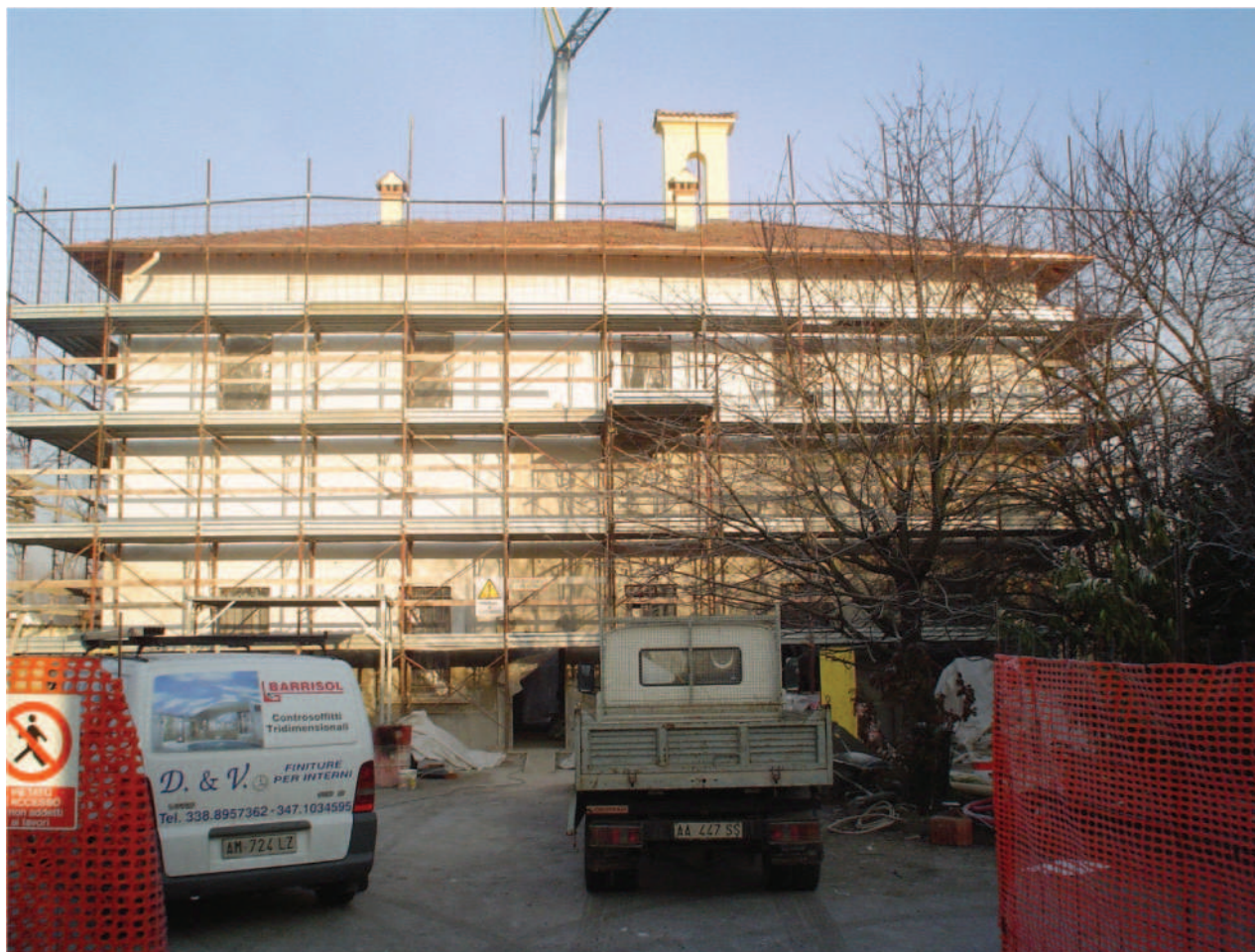
Particolare delle operazioni di restauro effettuate sull'edificio principale (1).
