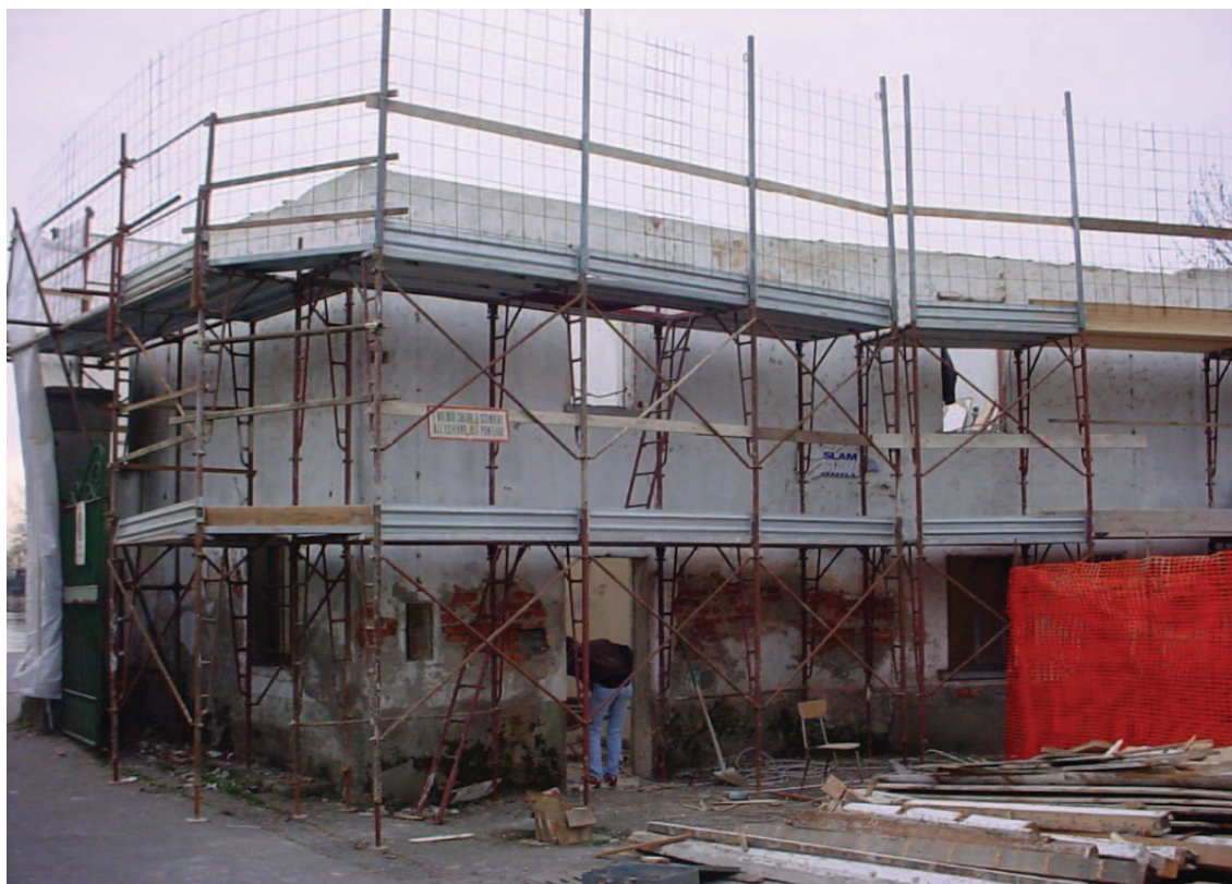
Edificio colonico (2): una fase delle lavorazioni.
