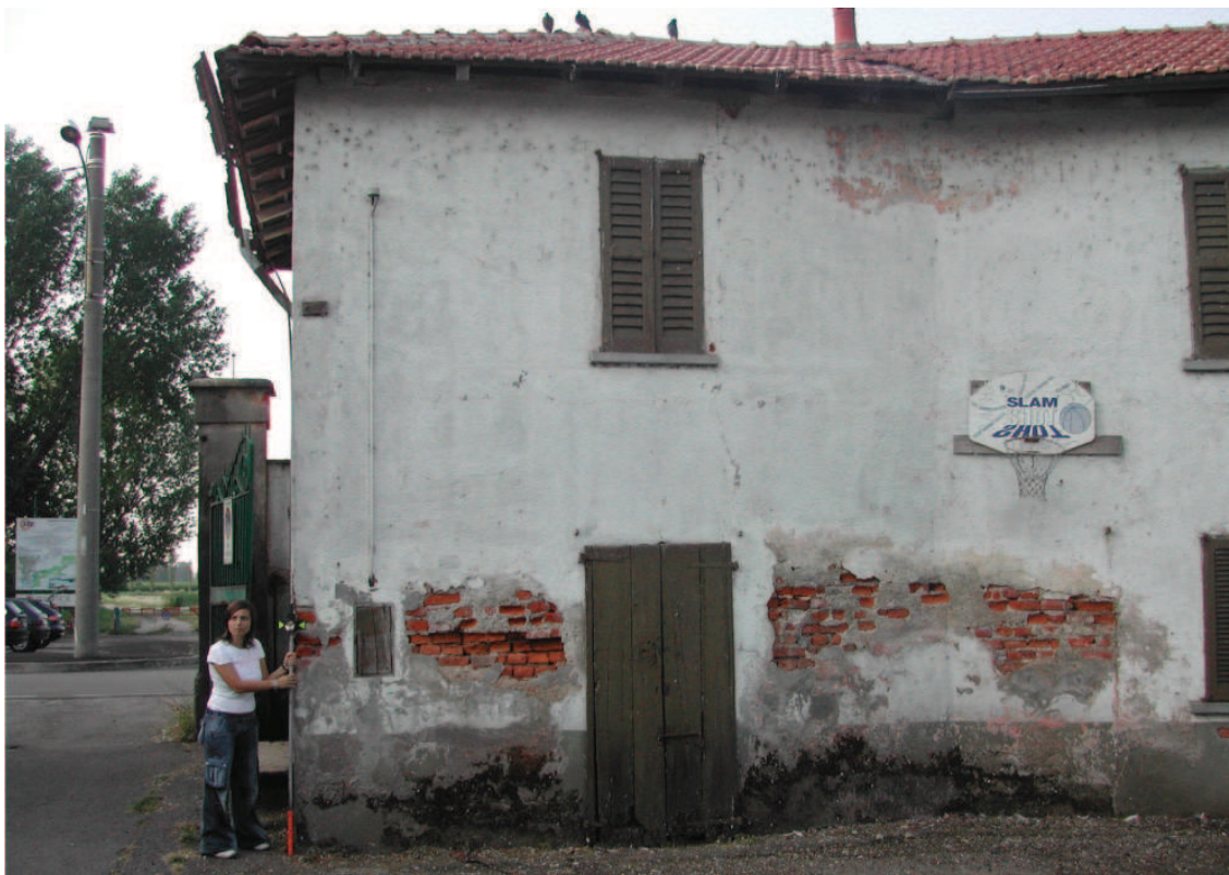
Fase di rilievo fisico-topografico.
