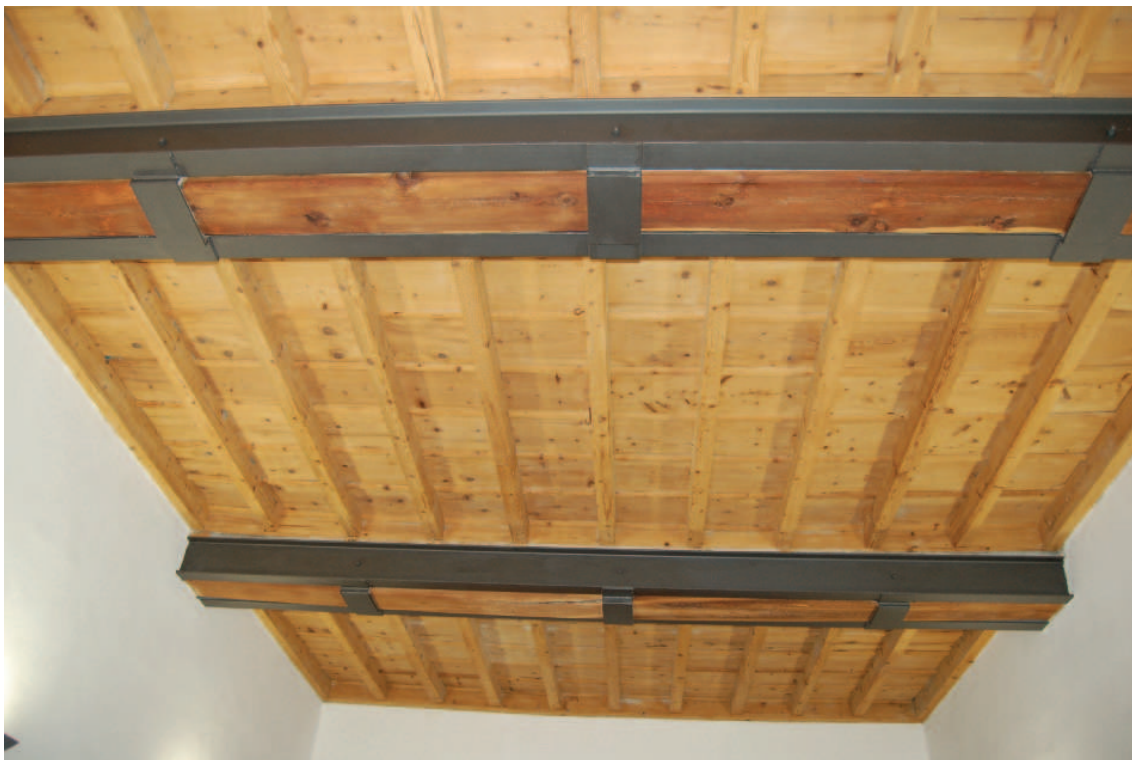
Particolare di come si presentava il colmo del tetto dell'edificio principale (1) dopo la rimozione dell'orditura minore.
