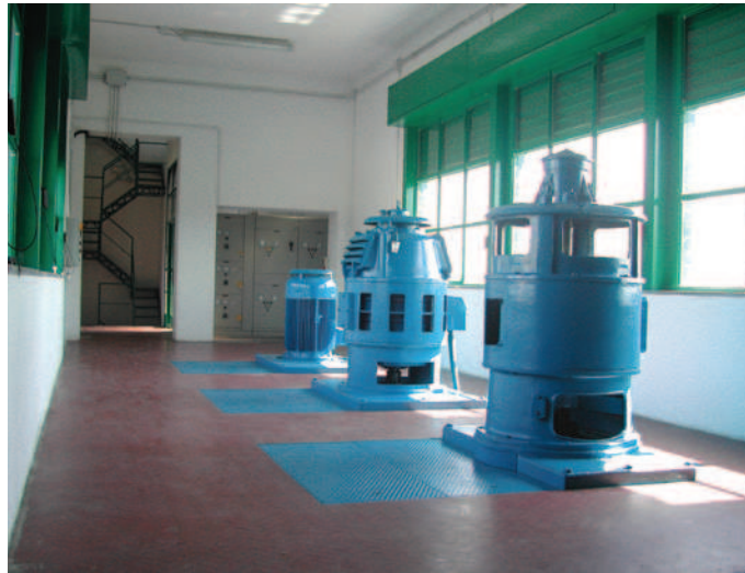
Tutti gli impianti funzionano in modo automatico in relazione alla misura istantanea dei livelli idrometrici. Avviamento e spegnimento sono telerilevati e telecontrollati a distanza con sistemi computerizzati. In alcuni di essi sono installate specifiche apparecchiature per la registrazione meteo-ambientale (temperatura, aria, piovosità, acqua, ecc.).
