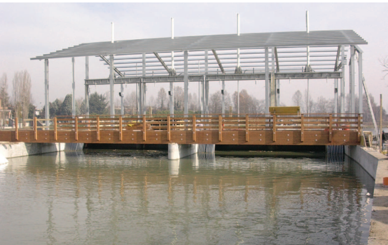
Un particolare (visto da monte) dello "scheletro" metallico strutturale dell'edificio in cui sono posizionate le due turbine; subito a monte la passerella in legno che collega le due sponde del Muzza.
