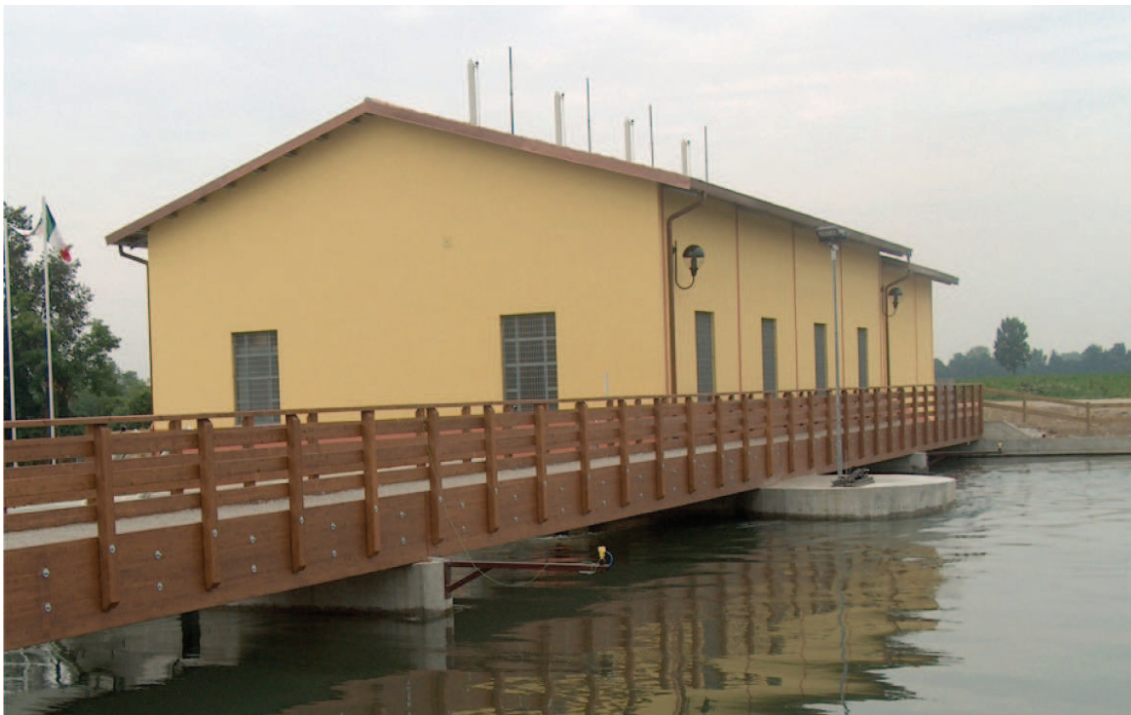
La centrale idroelettrica di Paullo, vista da monte in corrispondenza della passerella lignea che collega le sponde del canale Muzza.
