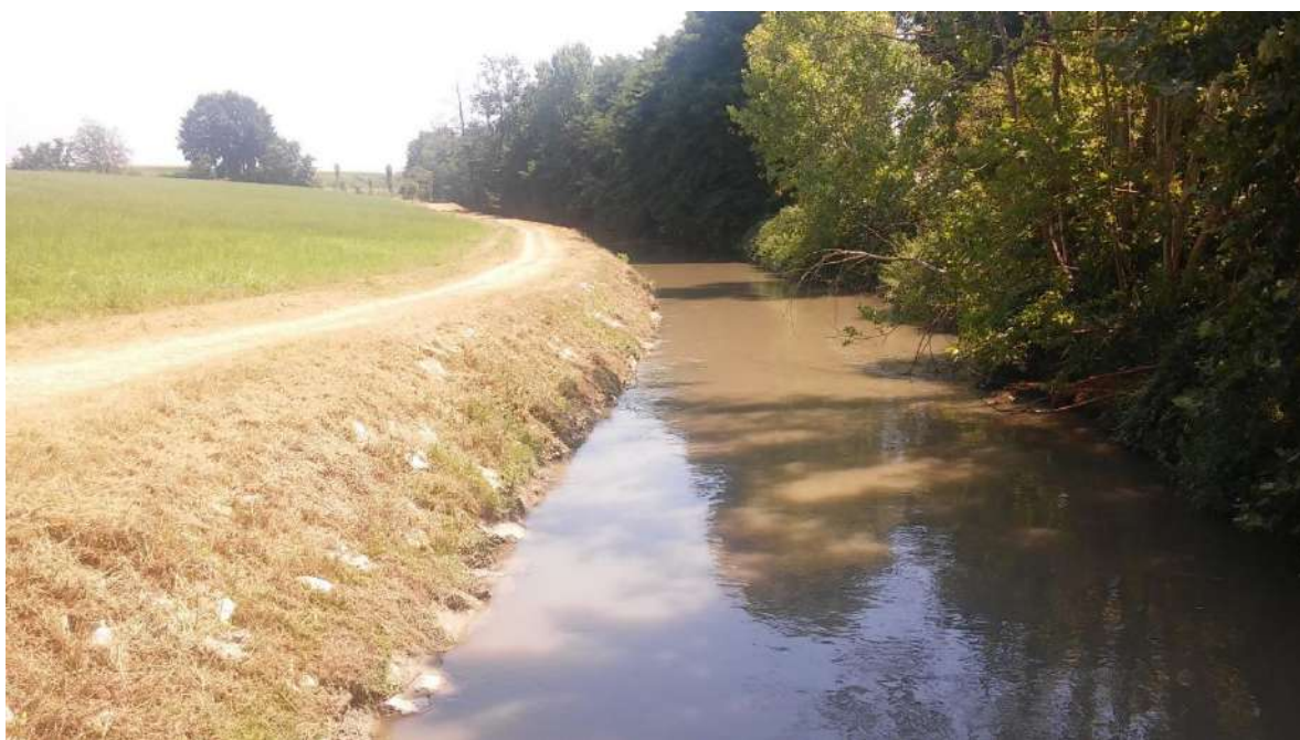
Colatore Venere – inserbimento del paramento spondale
