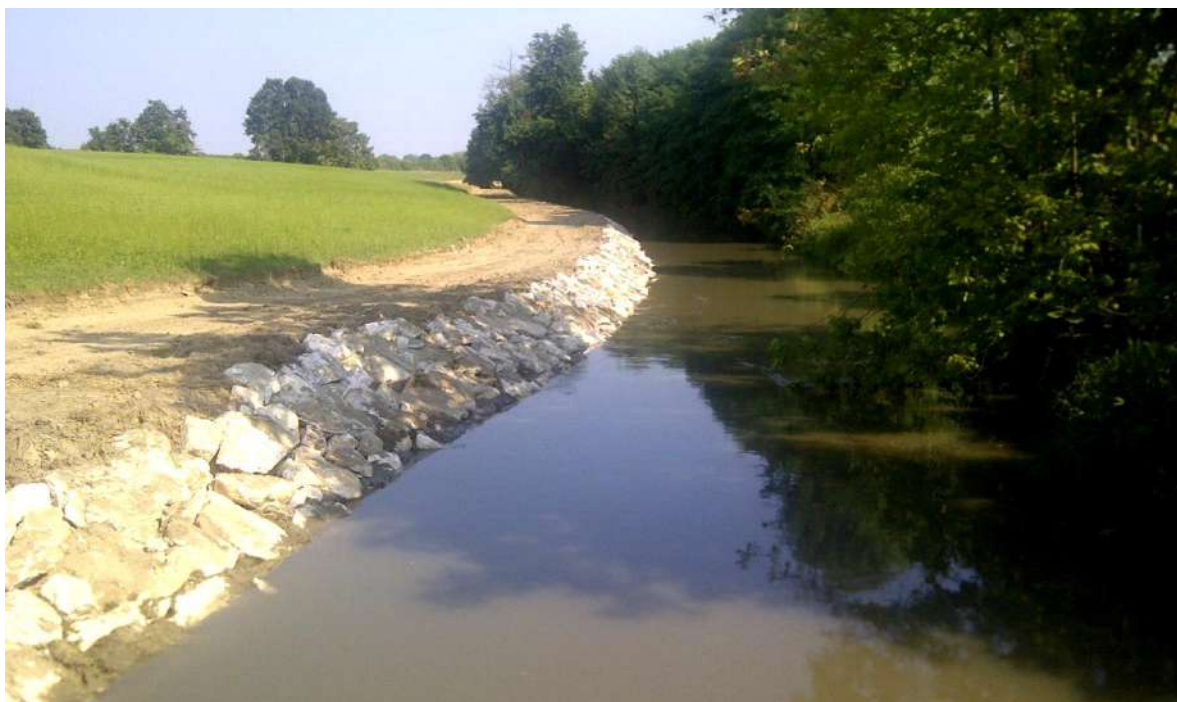
Colatore Venere – esecuzione di difesa idraulica in pietrame di tipo rezzato
