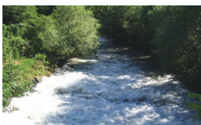
Sbarramento Biraghina sul Colatore Muzza
