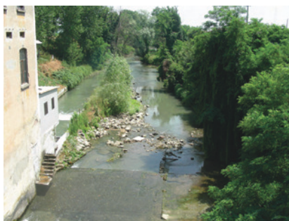
Sbarramento Colombina sul Colatore Muzza
