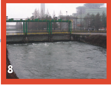
Centrale termoelettrica Endesa di Tavazzano
