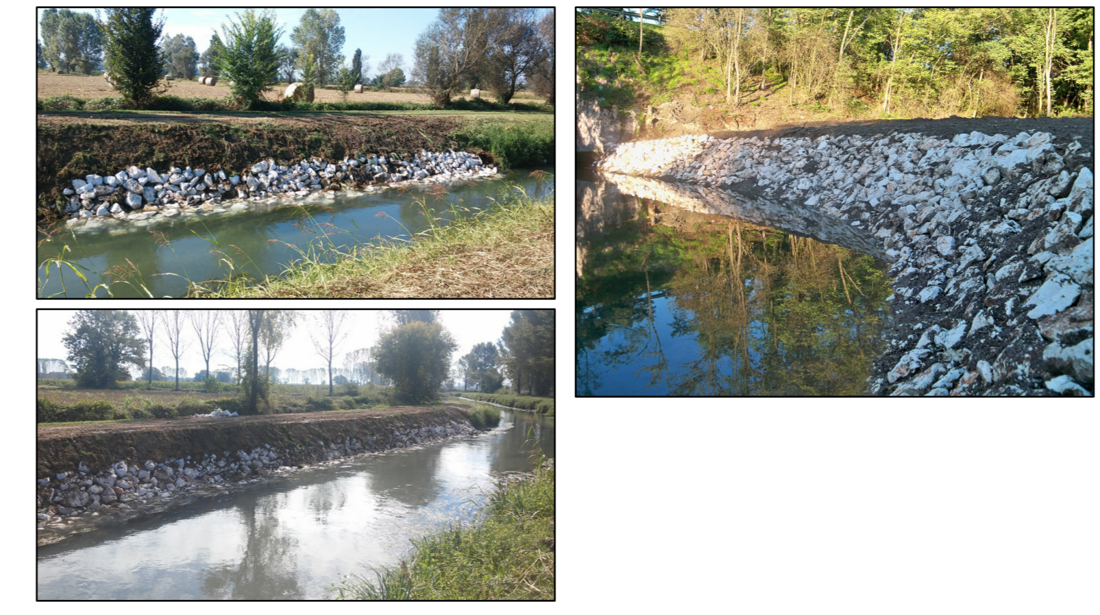
Esempi di rifacimento e ripristino di difesa di sponda con pietrame tipo "Rezzato"
