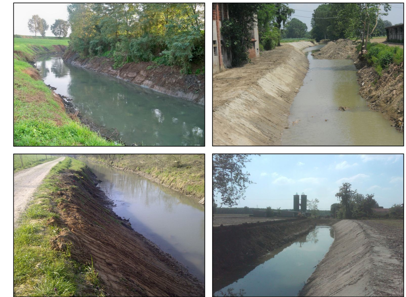
Esempi di ripristino del profilo d'alveo: una sponda finita ed una sponda ancora da eseguire
