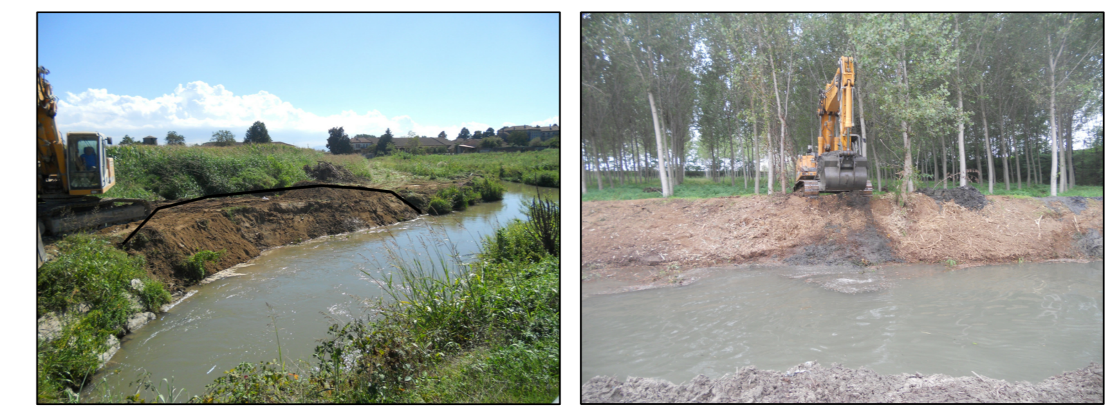
Esempi di riduzione di frana con integrazione di materiale terroso
