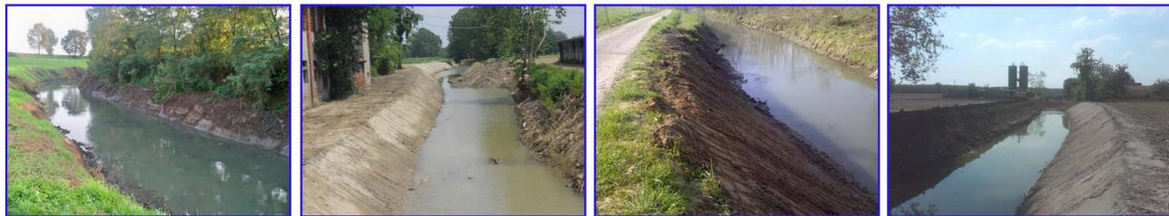
Esempi di ripristino del profilo d'alveo: una sponda finita ed una sponda ancora da eseguire
