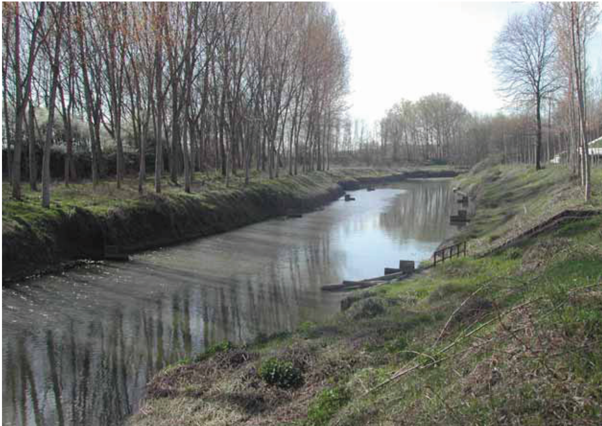
Il collettore principale di Bonifica, tratta "Gandiolo" nei pressi di Corno Vecchio.
