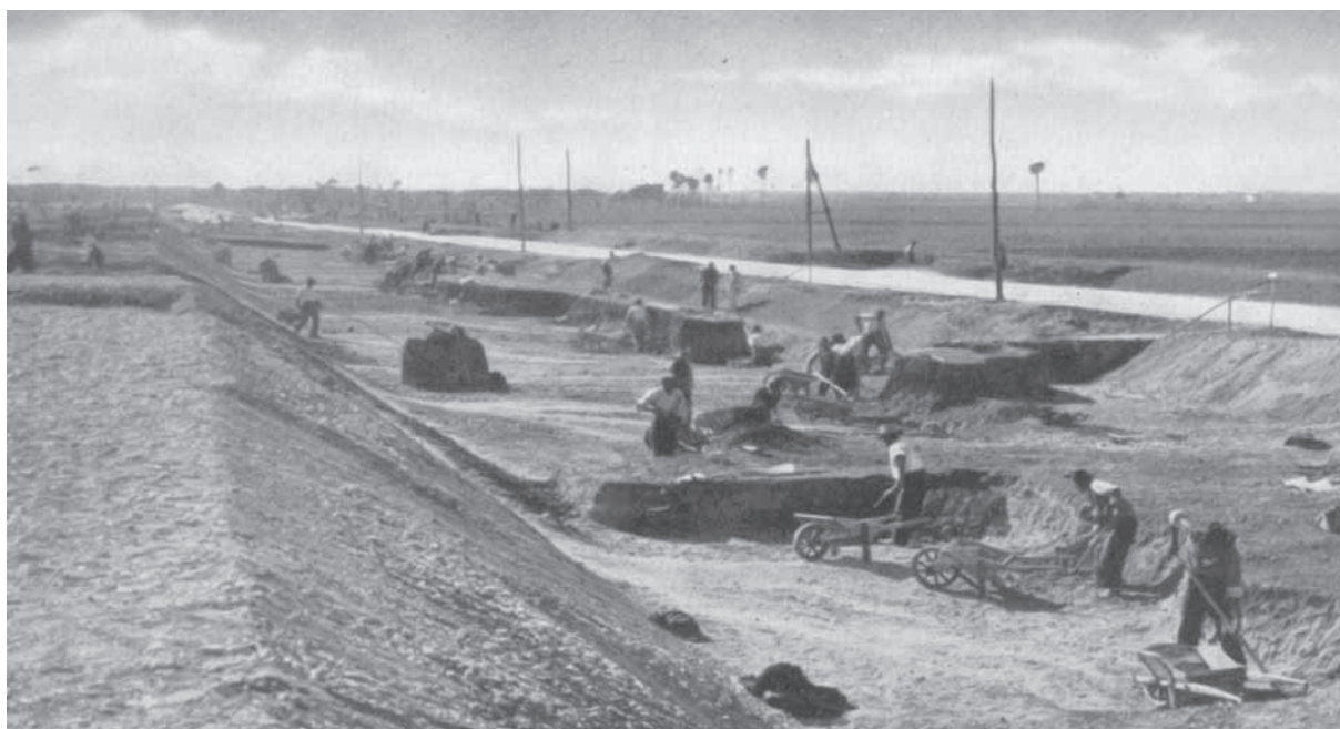
Lo scavo manuale di un canale di bonifica. Badile e carriola sono stati per secoli gli attrezzi più usati rispettivamente per scavo e trasporto del materiale.
