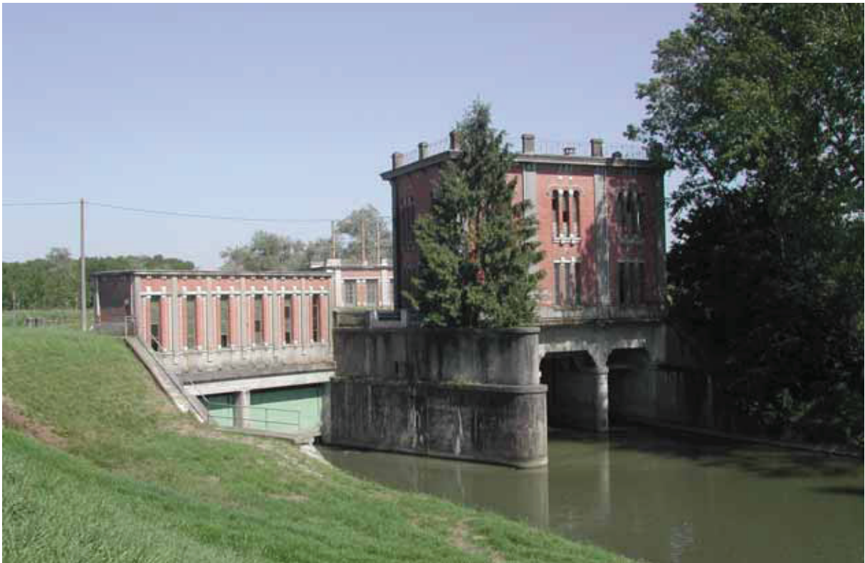
Il "Chiavicone" di S.Stefano, manufatto idraulico di deviazione dei deflussi. Quando i livelli bassi del Po lo consentono le acque vengono dirette immediatamente nel fiume stesso tramite lo scarico di destra. In caso contrario vengono deviate (con le paratoie di sinistra) nel canale "Allacciante" e quindi di nuovo in Po a Castelnuovo, potendo contare sul maggior dislivello disponibile. Questo accorgimento era già previsto dal progetto che l'ing. Antonio Tosi aveva elaborato nei primi anni del XIX secolo.
