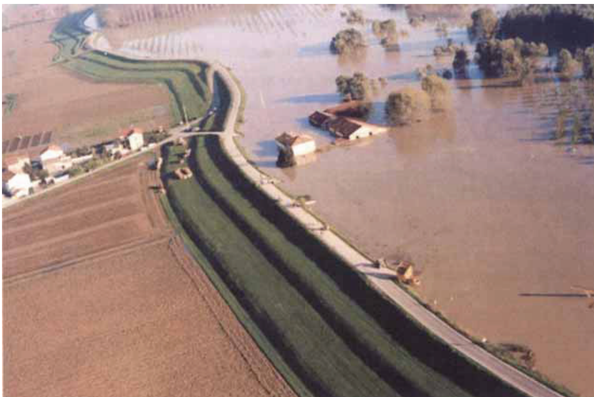
Fiume Po nel corso della piena del 2000. L'argine maestro è al limite del contenimento; all'idrometro di Piacenza veniva raggiunto il livello di + 10.50m sullo zero di riferimento. Campagne, abitazioni e strade soggiacevano di diversi metri dal livello del fiume.
