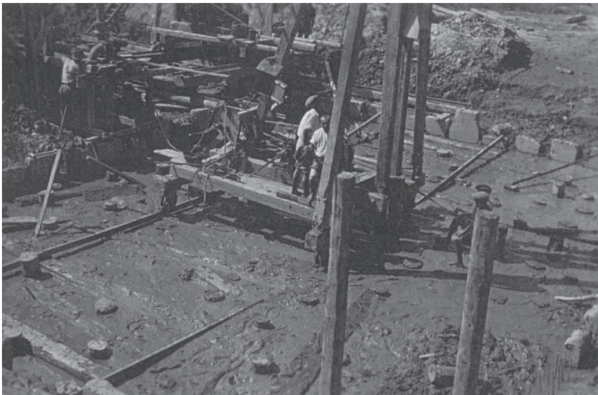
Immagine tratta dall'archivio del Consorzio di Bonifica Muzza Bassa Lodigiana relativa all'esecuzione dell'impianto idrovoro di Caselle Landi.
