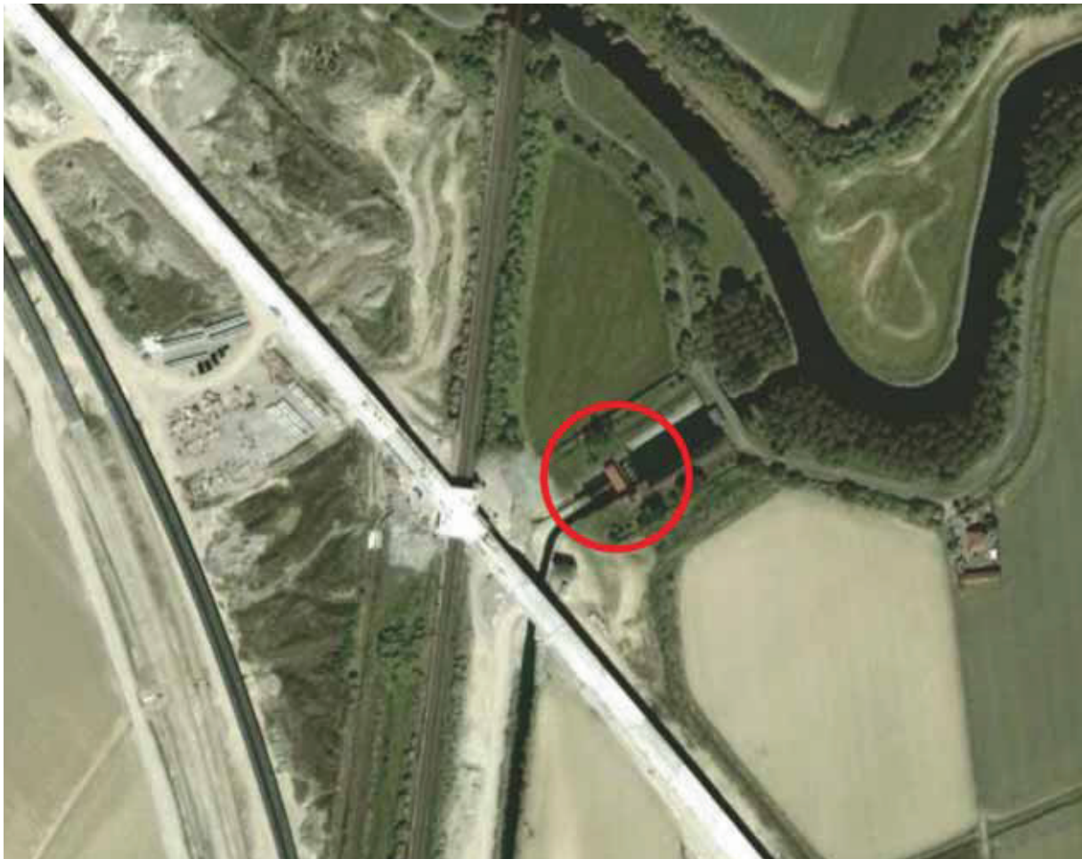
Impianto idrovoero di S. Rocco al Porto: vista esterna del fabbricato (sopra) e immagine satellitare.
