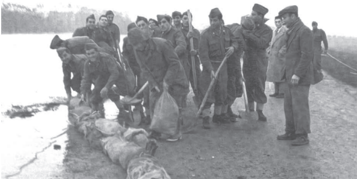
Piena del Po del 1951, militari e volontari trattengono la crescita idrica sopralzando l'argine maestro con sacchetti di sabbia. (immagine tratta da "Quando a San Rocco..." di M. Cavalloni ed. Assigrafica).
