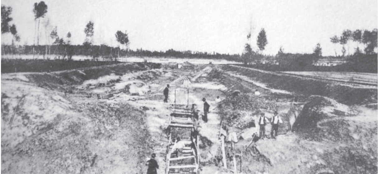
La costruzione dell'ultimo tratto di sfocio in Po presso Castelnuovo, del collettore principale di bonifica. Questo tratto è intitolato ad Antonio Tosi.
