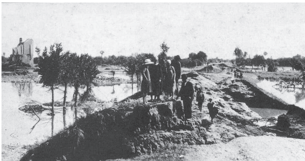
Una rotta d'argine a seguito della piena del 1928; sono ben visibili gli allagamenti e le erosioni provocate nel territorio.
