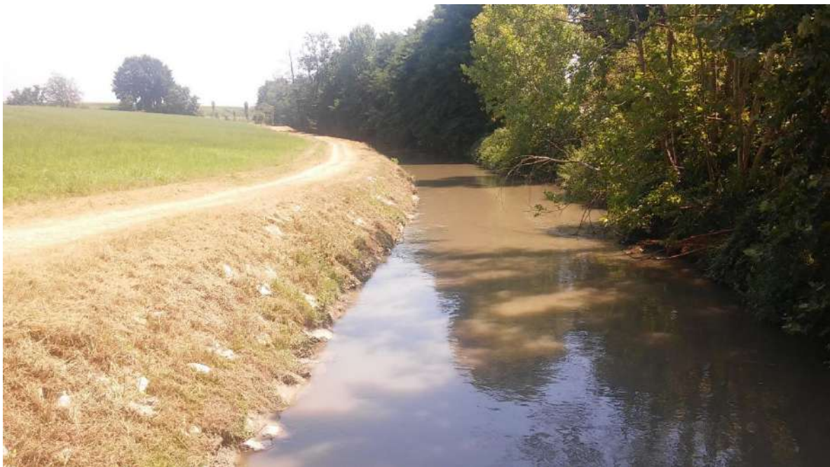
Colatore Venere – inserbimento del paramento spondale
