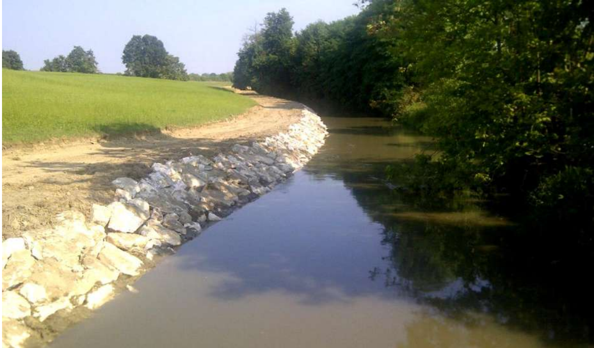
Colatore Venere – esecuzione di difesa idraulica in pietrame di tipo rezzato
