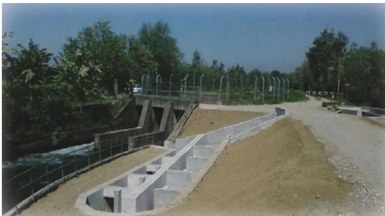
Fig. 6.1.4 – Scala di rimonta ittica al terminal del canale Muzza al nodo idraulico di Massalengo: collegamento con il colatore Muzza, vista da valle
