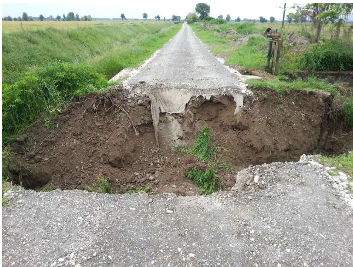
Figura 6.1.30 - Asportazione di argine intermedio carrabile tra corsi d’acqua appaiati a seguito di commistione idraulica per escavazione di gallerie comunicanti effettuato da nutrie
