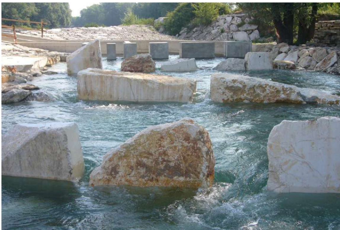
Figura 6.1.6 – Scala di rimonta ittica al manufatto sfioratore Traversino di Cassano d’Adda: particolare del passaggio tra i setti in pietrame
