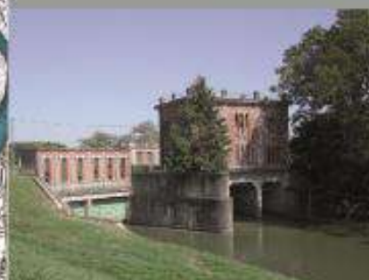
Il "Chiavicone" di S. Stefano, manufatto idraulico di deviazione dei deflussi (3). Quando i livelli bassi del Po lo consentono le acque vengono dirette immediatamente nel fiume stesso tramite lo scarico di destra. In caso contrario vengono deviate (con le paratoie di sinistra) nel canale "Allacciante" e quindi di nuovo in Po a Castelnuovo, potendo contare sul maggior dislivello disponibile. Questo accorgimento era già previsto dal progetto che l'ing. Antonio Tosi aveva elaborato nei primi anni del XX secolo.
