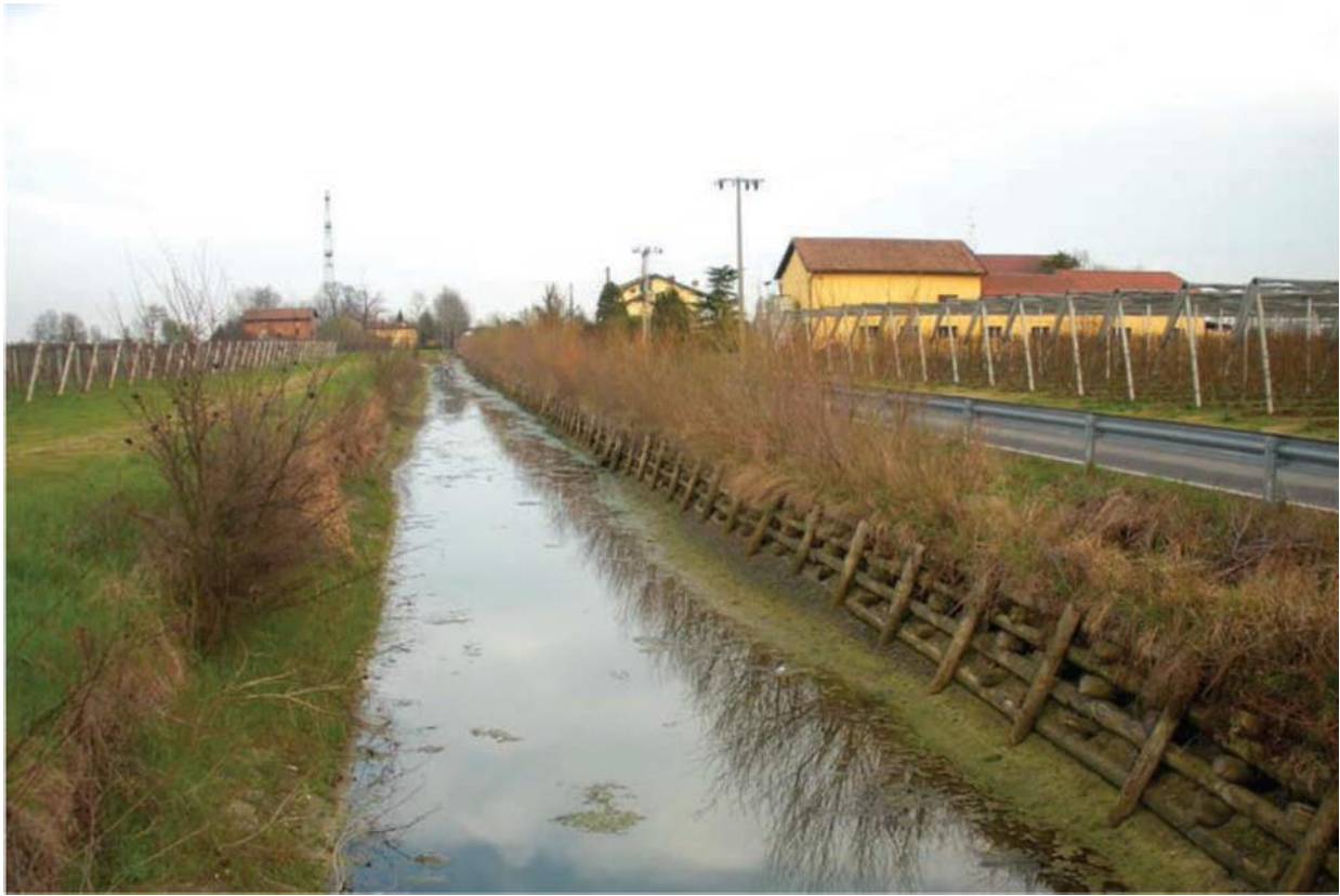
Fig. 4 – Palificata rinverdita nel periodo autunnale, dopo qualche anno dalla fine dei lavori (Fonte: Linee Guida Riqualificazione Canali, Regione Emilia Romagna)
