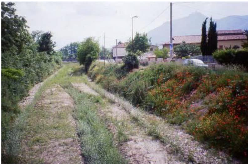
Fig. 8 - Realizzazione di savanella di magra nel caso di portata scarsa e intermittente per concentrare le acque per il mantenimento degli habitat igrofili . Acque concentrate in un alveo di magra. Rio Inferno Cassino (FR). Foto P. Cornellini
