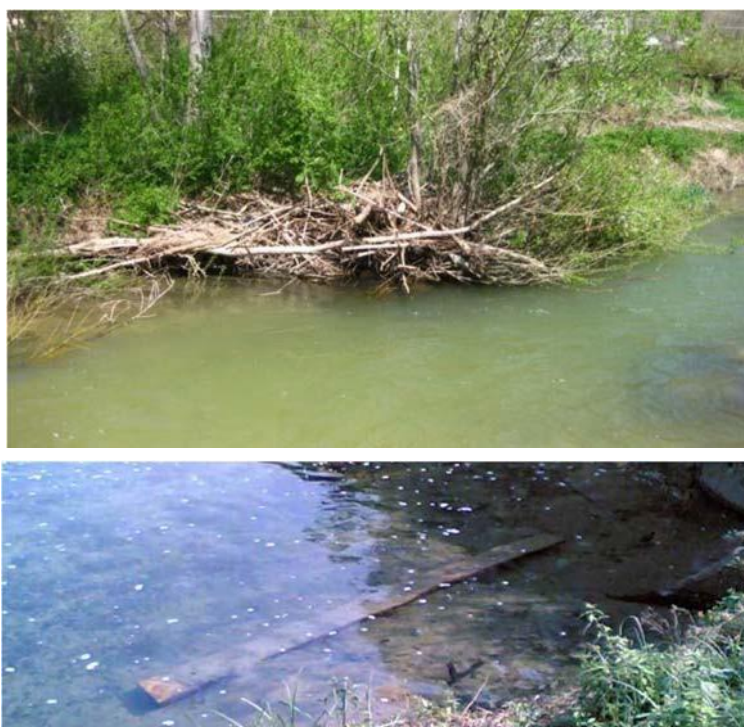
Fig. 9-10 - Introduzione in alveo di detriti legnosi in forma di cumuli (Large Woody Debris) o di semi tronchi necessari per incrementare la diversità morfologica e garantire alla fauna ittica zone di rifugio dai predatori e dalle piene. Foto L. Ruggieri (Fonte: Linee Guida Riqualificazione Canali, Regione Emilia Romagna)
