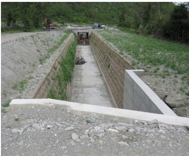
Fig. 2-3: Scatolari prefabbricati in associazione con terre rinforzate o tallee
