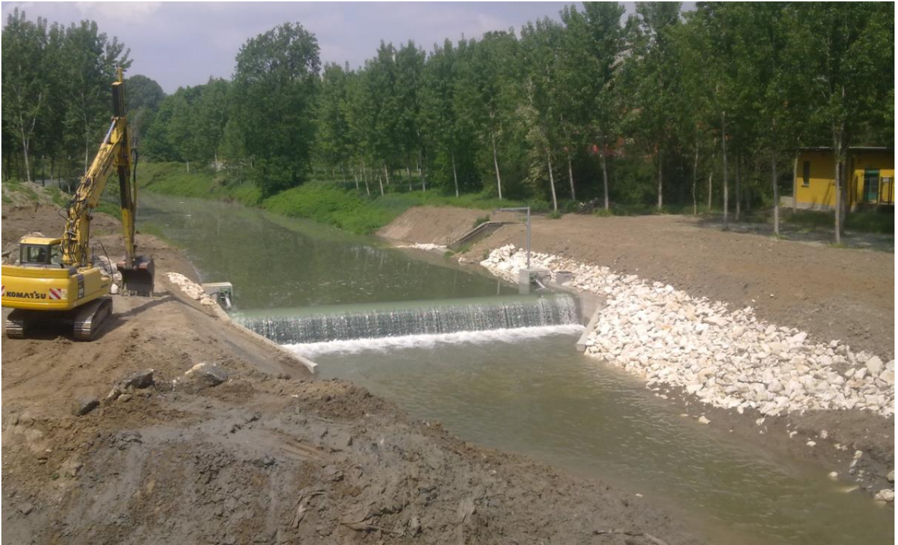
12 - Fase di esercizio: completato il sollevamento della traversa
