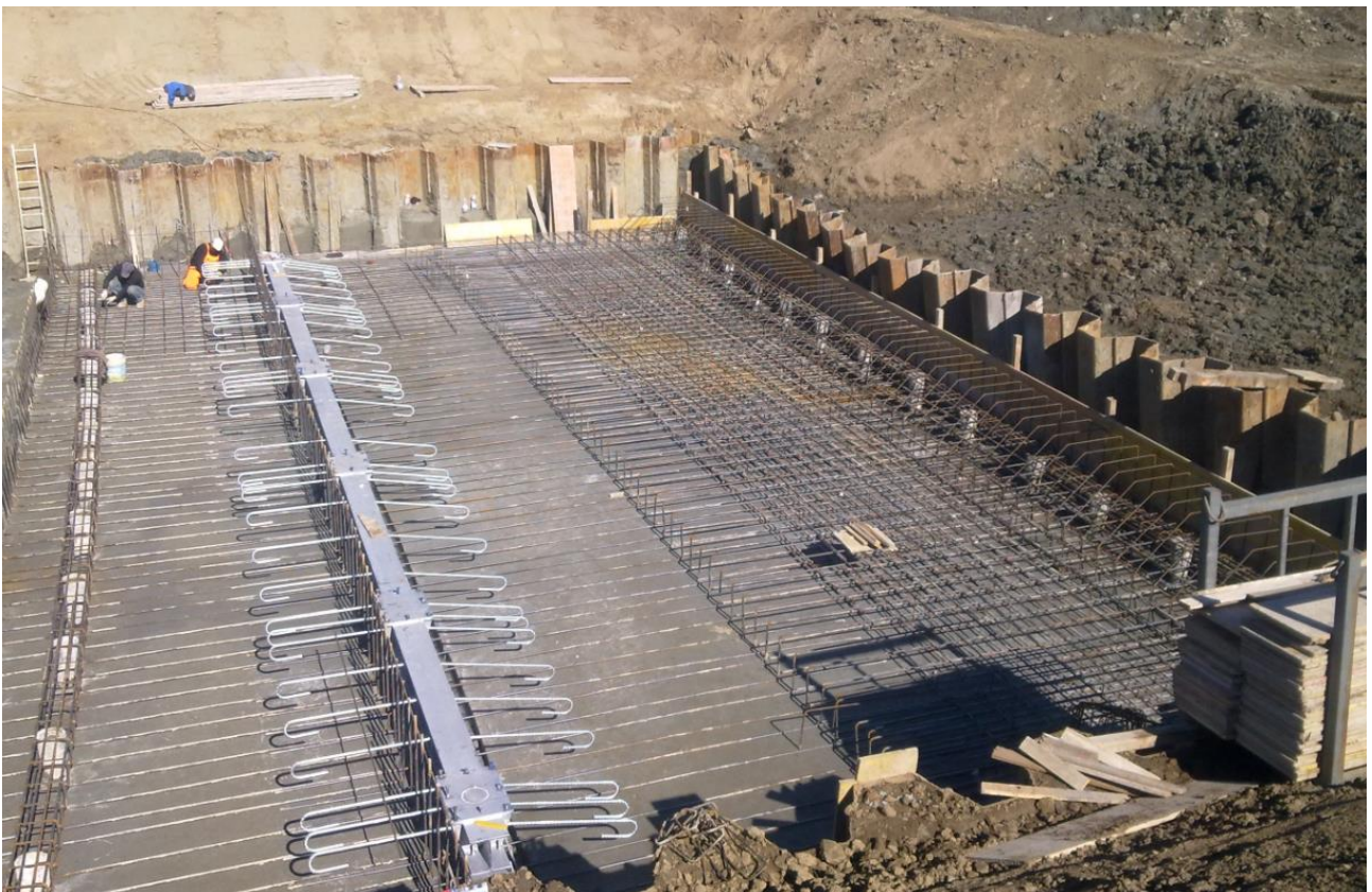
4 - Fase di cantiere: armatura della platea
