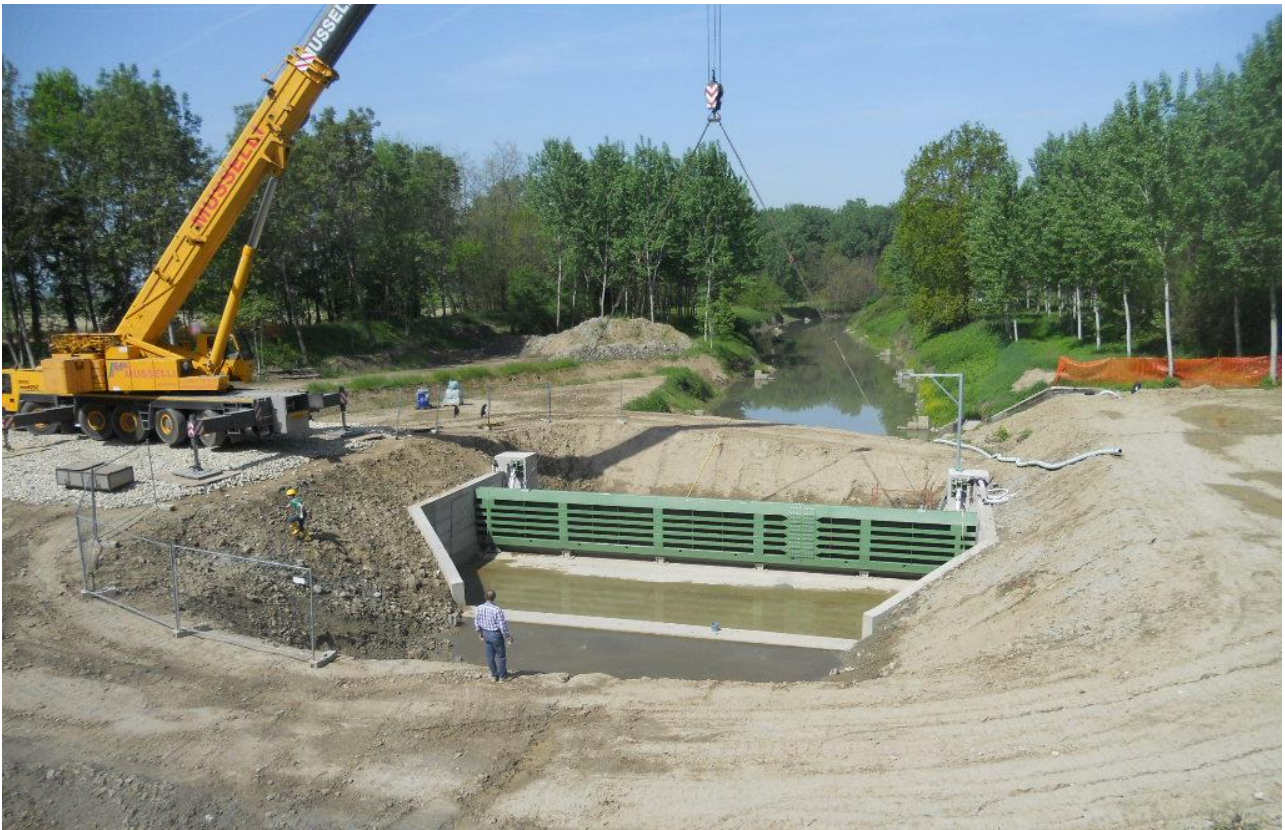
7 – Fase di cantiere: fornitura ed installazione della briglia
