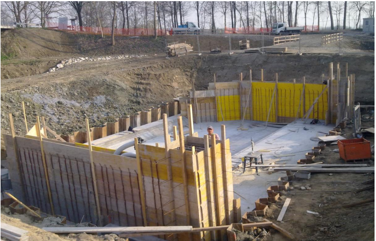
5 - Fase di cantiere: costruzione dei muri laterali
