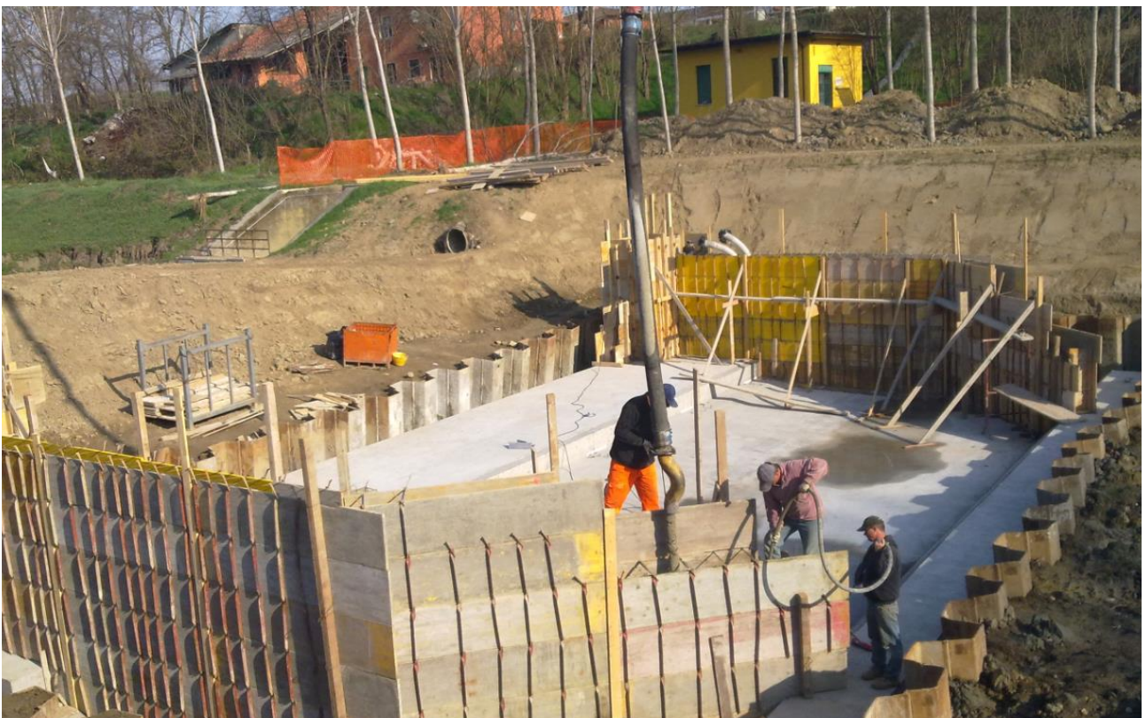
6 - Fase di cantiere: getto in calcestruzzo dei muri laterali
