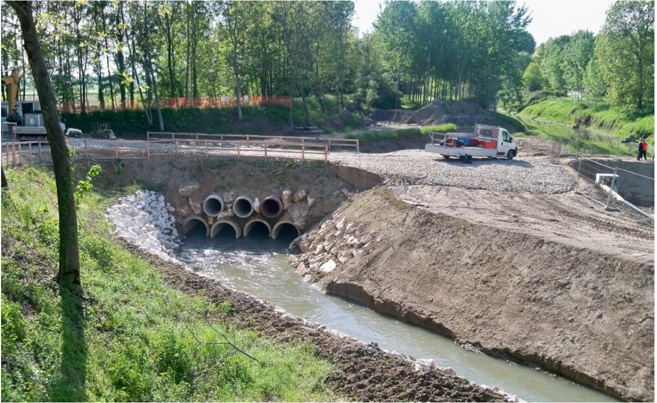
1 - Opere provvisorie: formazione canale di bypass per mantenere continuità idraulica
