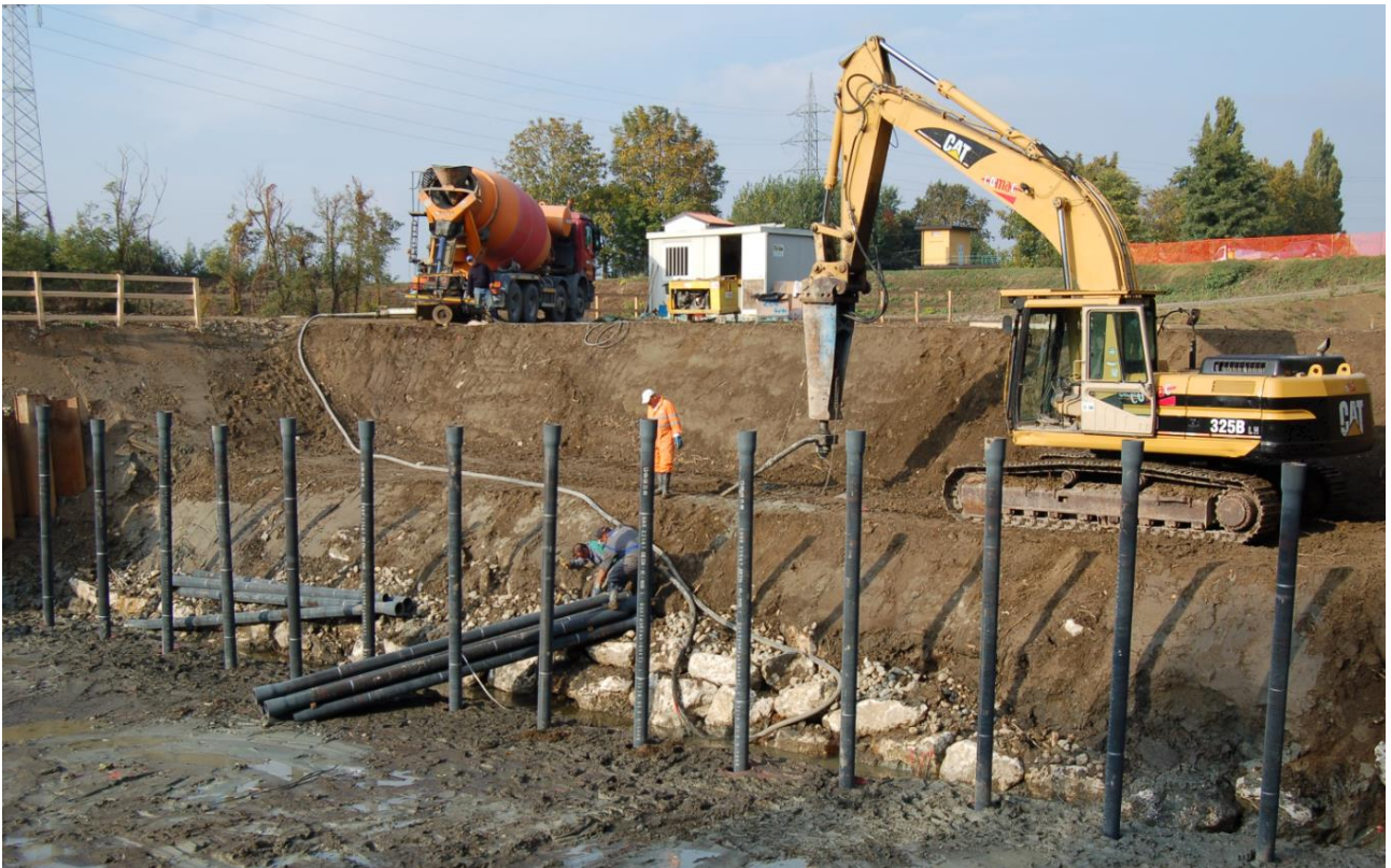
2 - Fase di cantiere: infissione dei pali di fondazione al di sotto della platea
