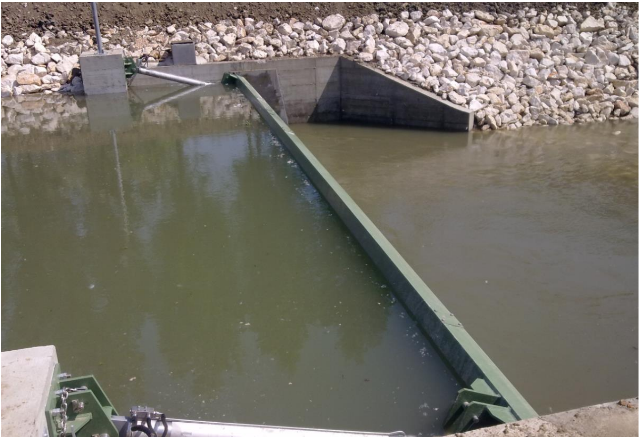
10 - Fase di esercizio: sollevamento della traversa
