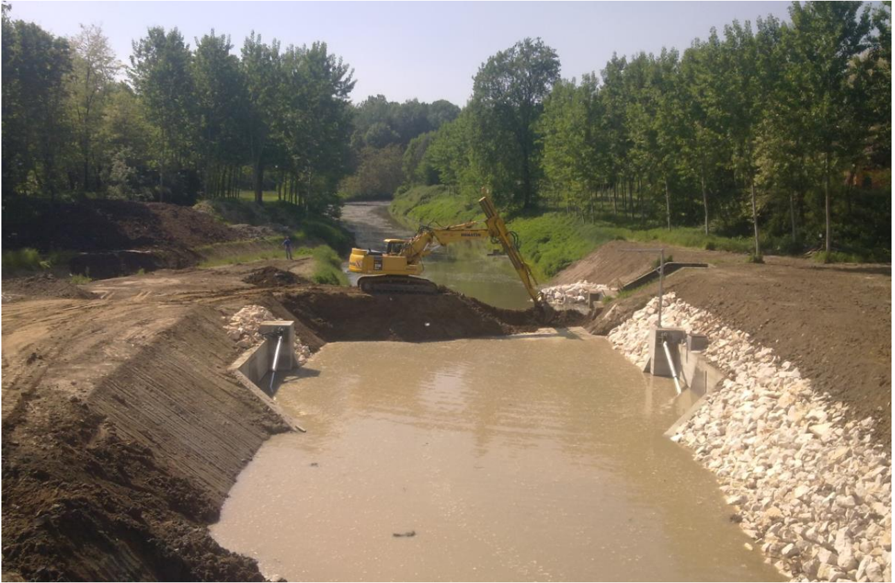
9 – Ripristino dello stato dei luoghi: rimozione della tura in terra di monte
