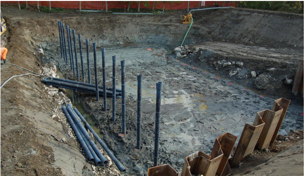
3 - Fase di cantiere: infissione dei pali di fondazione e getto del magrone di sottotondo della platea
