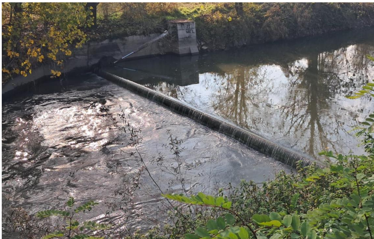
16 – Particolare della traversa in fase di sollevamento, a breve tempo dalla realizzazione
